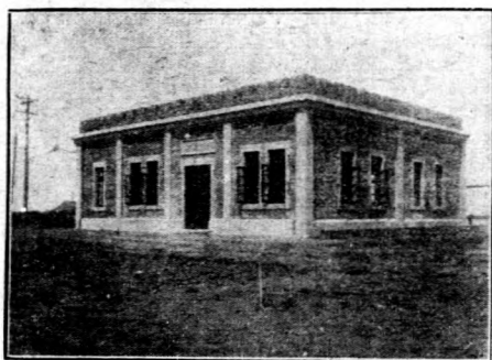
水 廠 混 水 機 室
