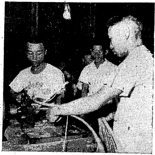
零陵县沙头镇竹器社，为了赶制双抢工具支援农村，他们利用电力做旋器破篾，大大提高了工效。这是社员正在用旋器破篾。(唐大柏摄)
