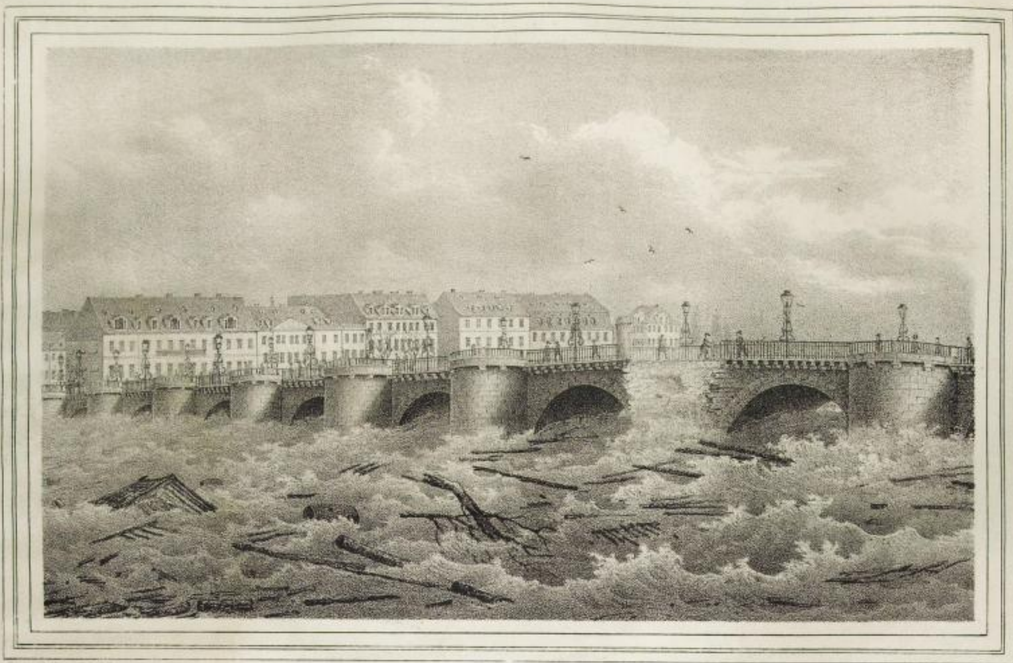
ANSICHT DER ELBBRÜCKE ZU DRESDEN nach dem Einsturz des Kreuzfyr u. Beschädigung des Brückenkopfseits.
