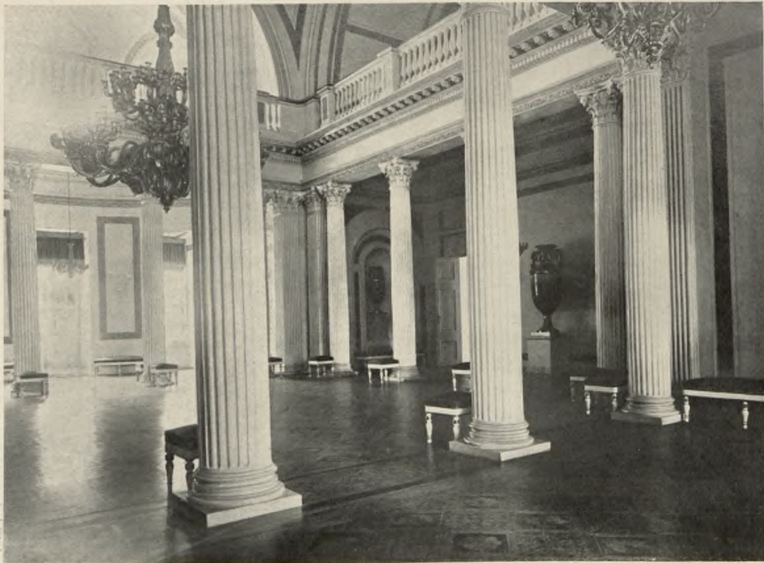
Колонная зала въ Гомельскомъ дворцѣ.
