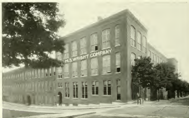
M. S. WRIGHT CO. PLANT
