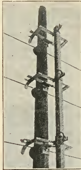
Fig. 65. — Détail des contacts de la prise de courant avec une perche.
