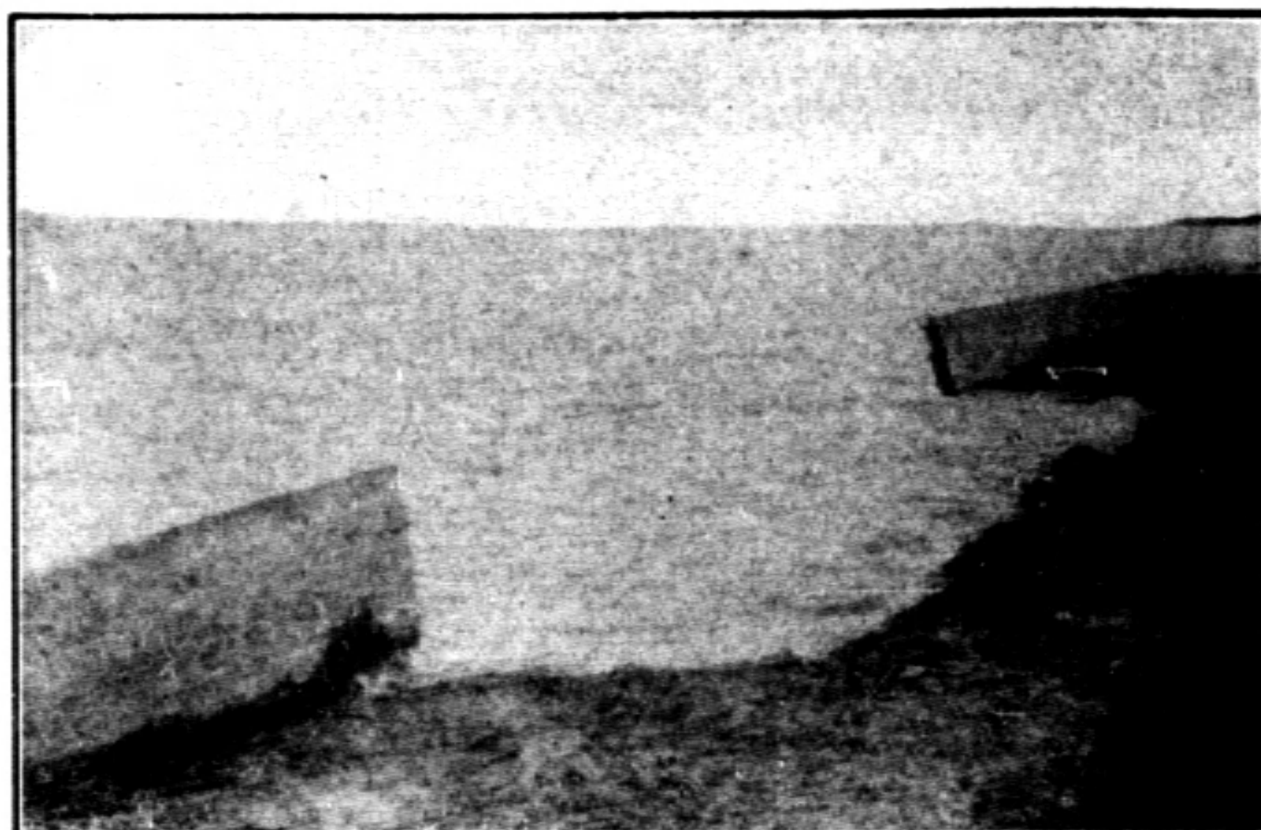
(14)鐵筋混凝土塘倒塌之狀(遷遷段)
