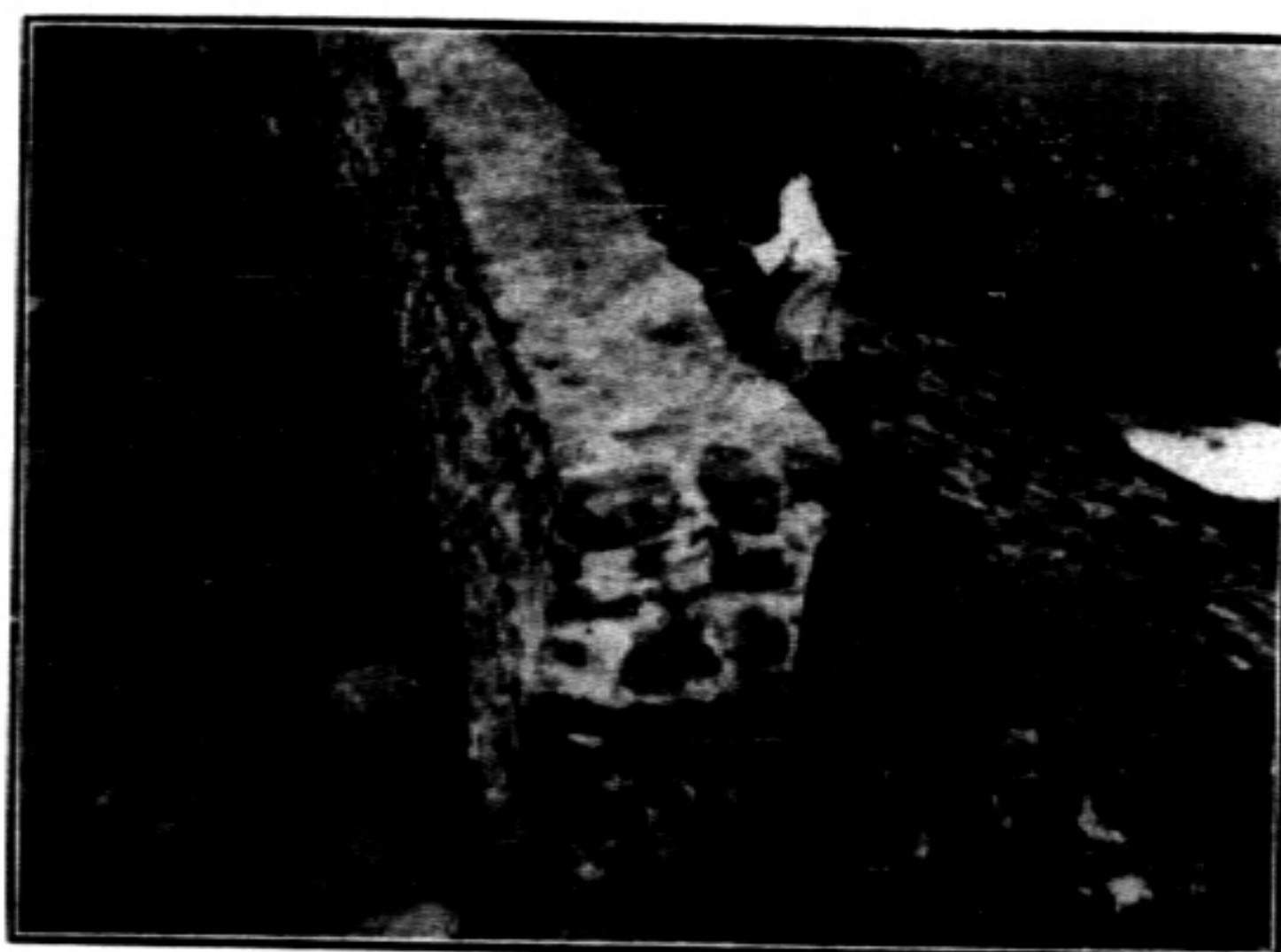
(8) 膠砌頭層石完成
