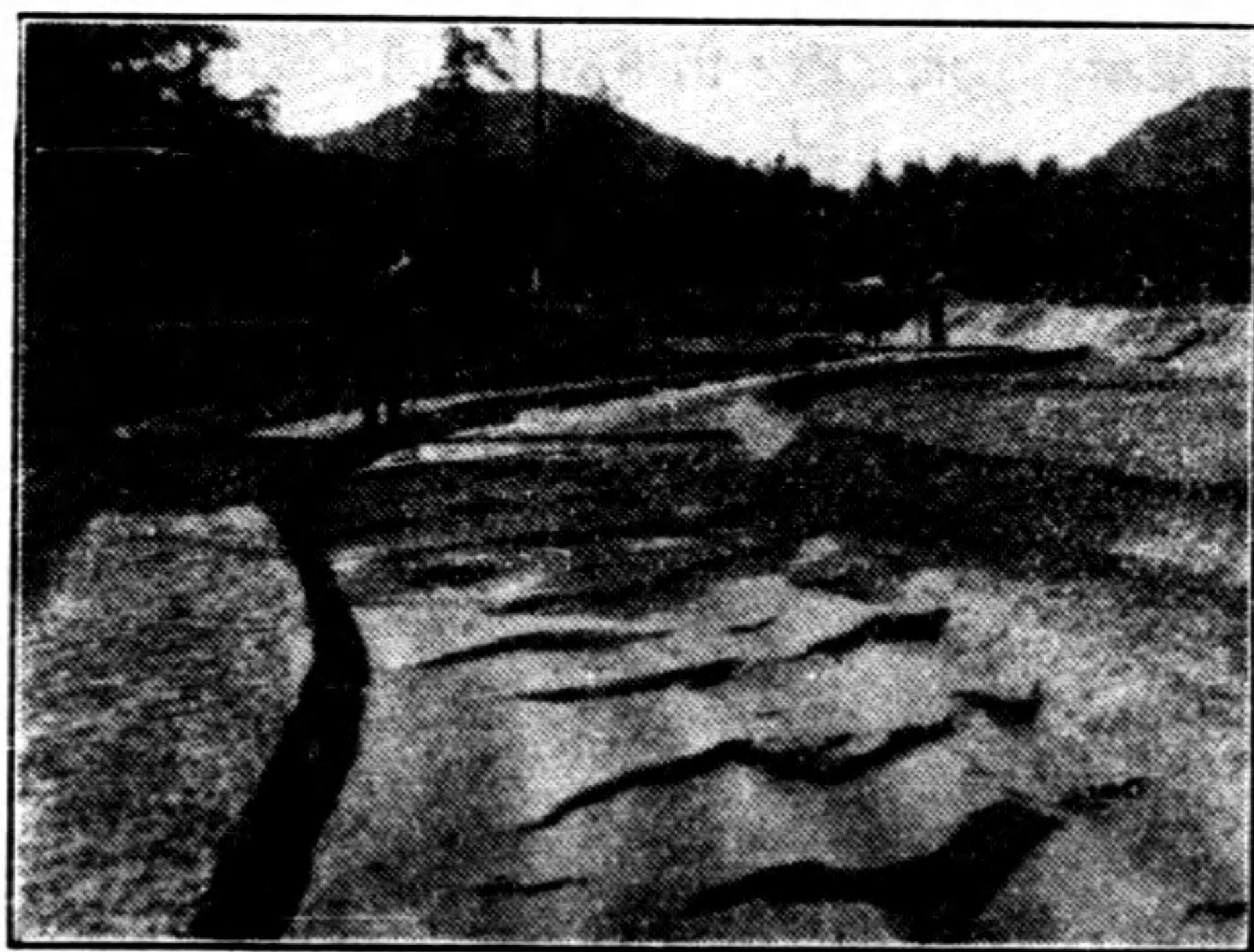
第四圖 洪水後試驗槽所起之變化
