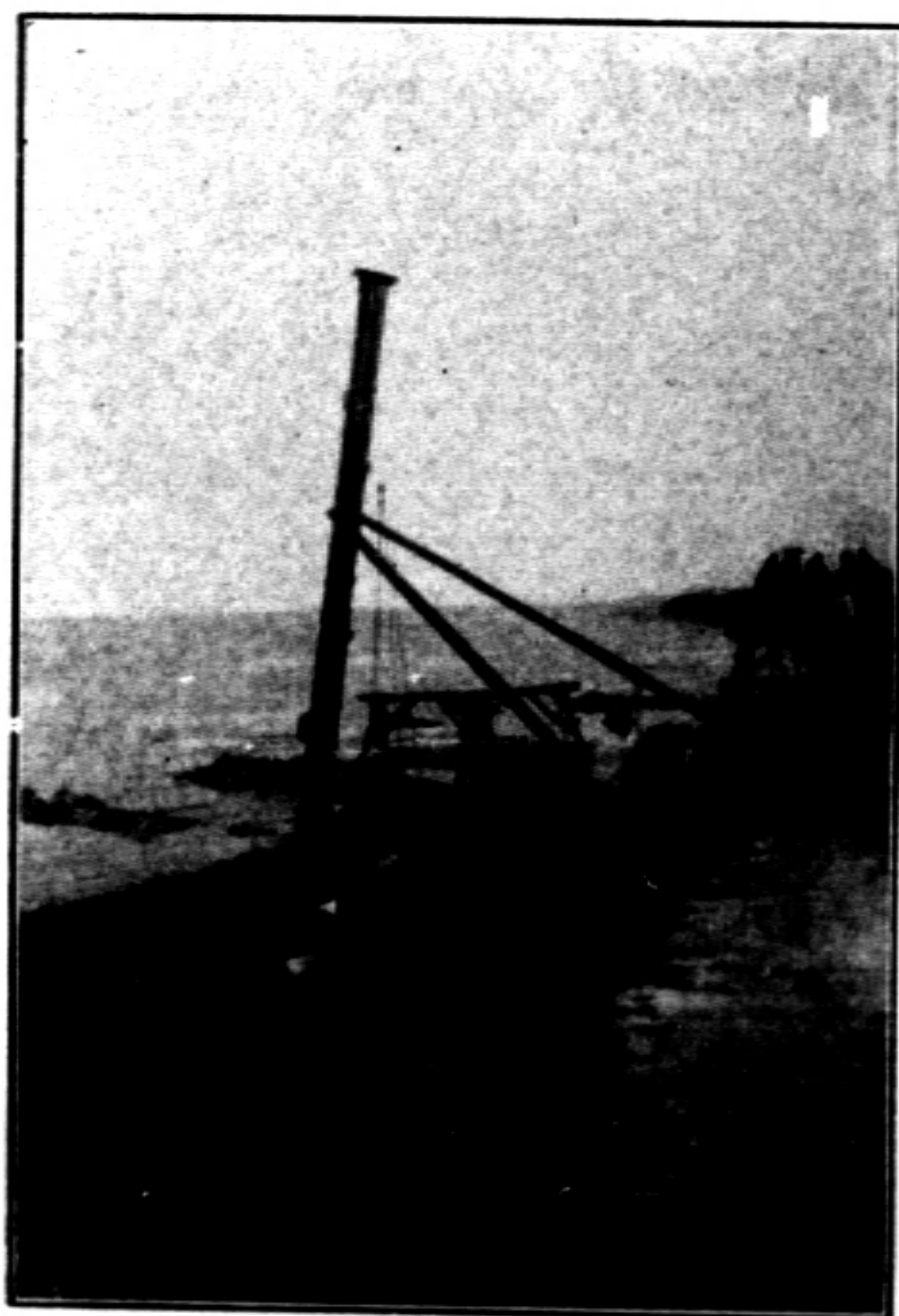
(6) 三脚打樁架(校正頭層樁高度)
