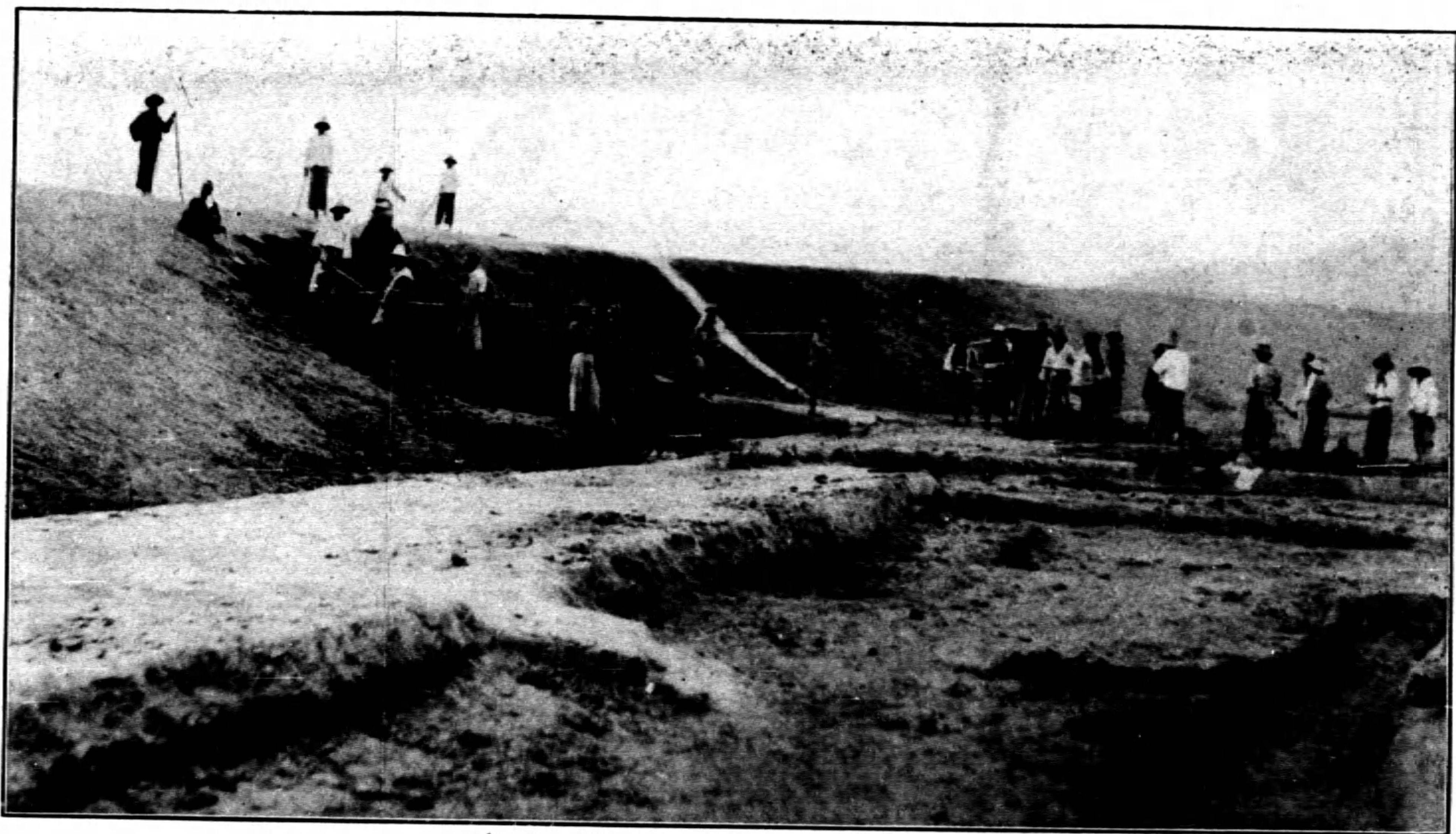
(三) 災工修築堤坡
