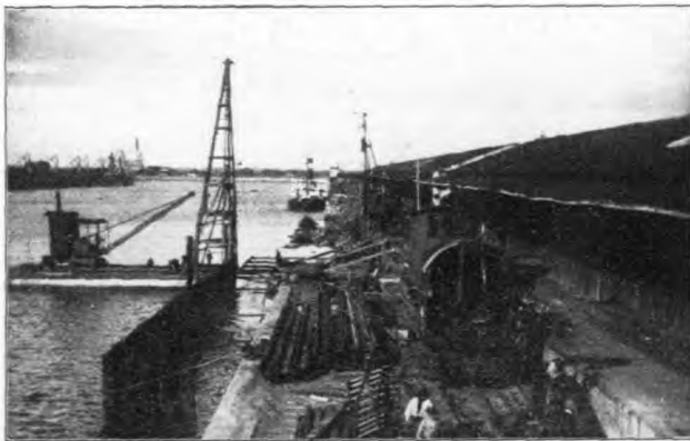
第十三圖 此圖所指示者為關於上述港口工程所築抽水 閘之建設。其構造用拉伸式之鋼片樁。
