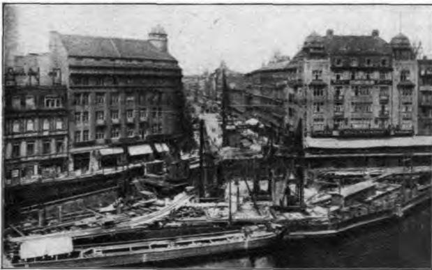
第二十二圖 上圖所表示者為司潑里河之水下隧道之構造。
