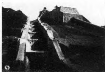
圖二十四 雲南省昆明第二水力廠之水閘及消耗水力門
