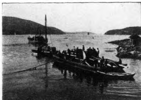
圖三十三 售與挪威安瀝滙的(Aalsund)，通 22000 Volts 電壓，長 10000 英尺之江底電索
