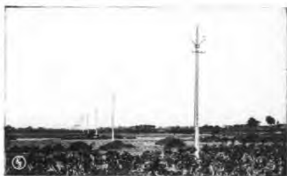
圖二十五 震華電機製造製之建於無錫成墅裝間之 33000 Volts 高壓電線塔
