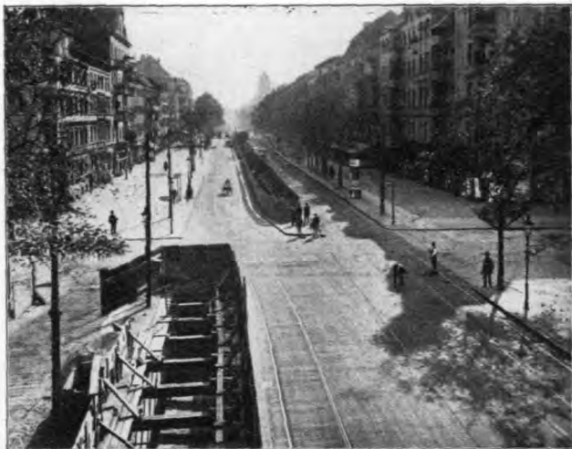
第二十圖 上圖所表示者為開掘街道準備建造隧道。
