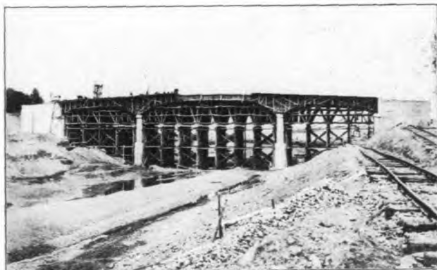
第七圖 中部之築架及右部之水泥工作桑農河上之黑水橋
