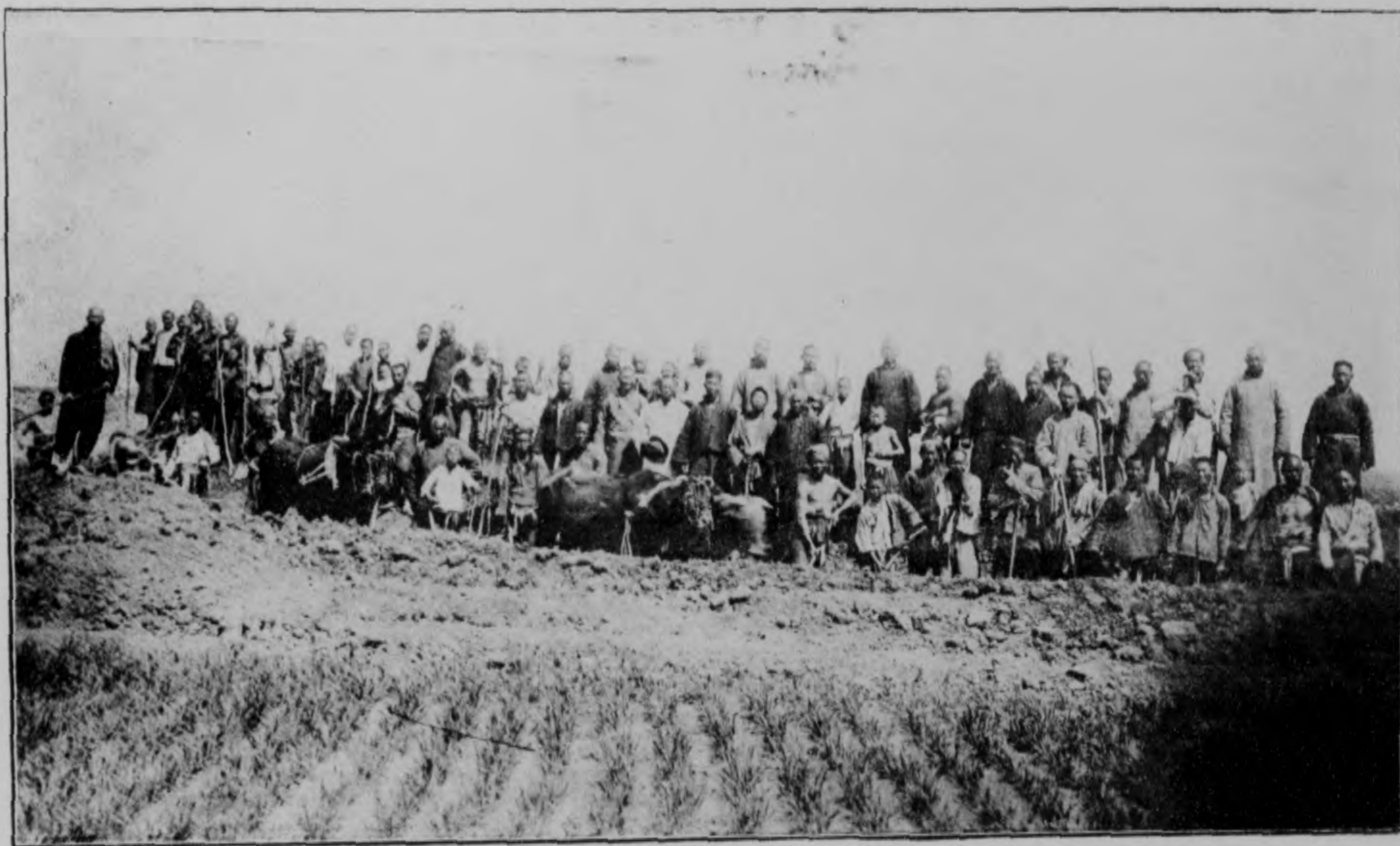
丹衛水利局開挖第一支渠圖
