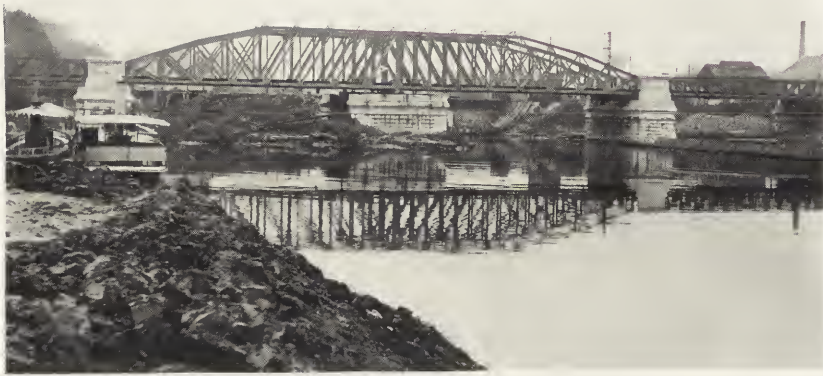
PONT SUR LE CANAL DE WILLEBROECK, A LAEKEN
