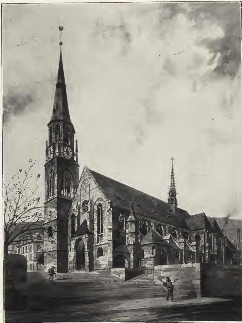
ÉGLISE ST JOSEPH, A GROMBUHL (WURTZBURG) VUE DU SUD-OUEST.
