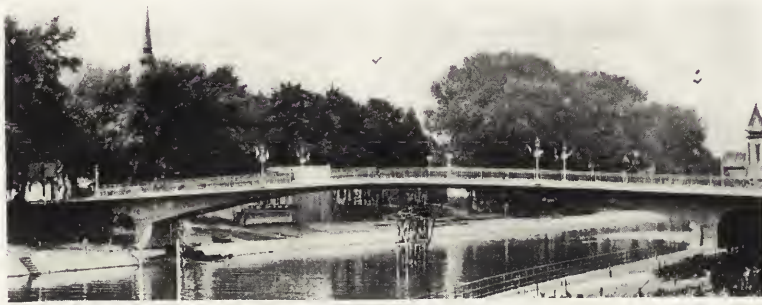
PONT EN BÉTON ARMÉ, SUR L'OURTHE, A LIÈGE.
