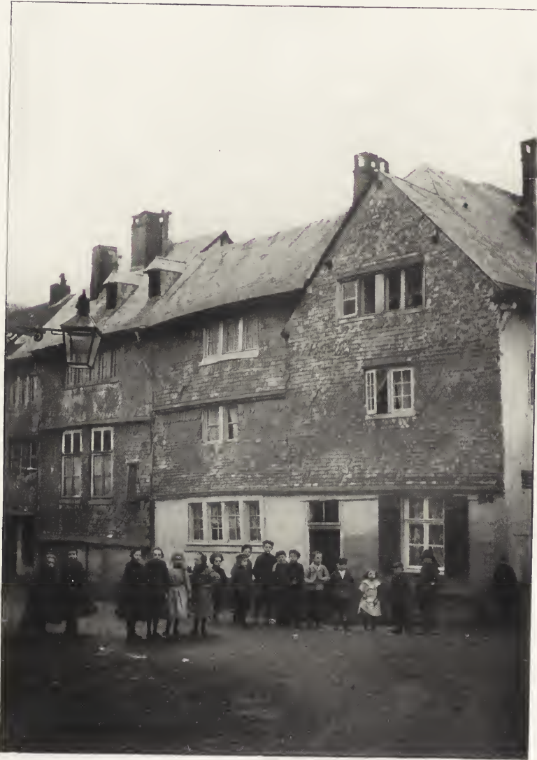
ANCIENNES MAISONS REVÊTUES D'ARDOISES, A ENSIVAL (VERVIERS).
