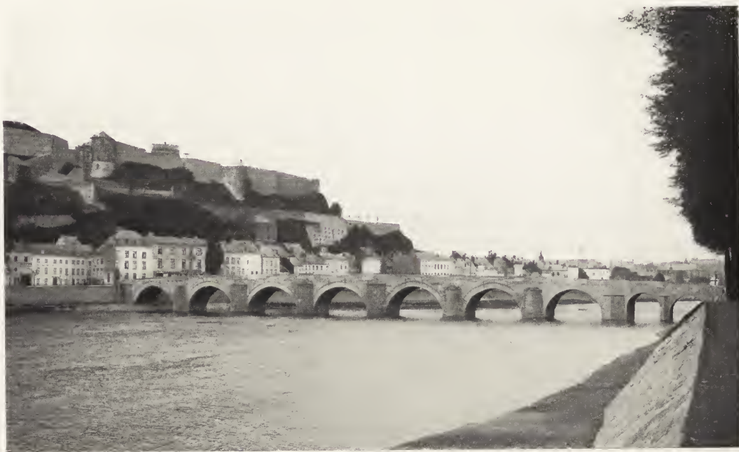
PONT SUR LA MEUSE, A JAMBES-LEZ-NAMUR.
