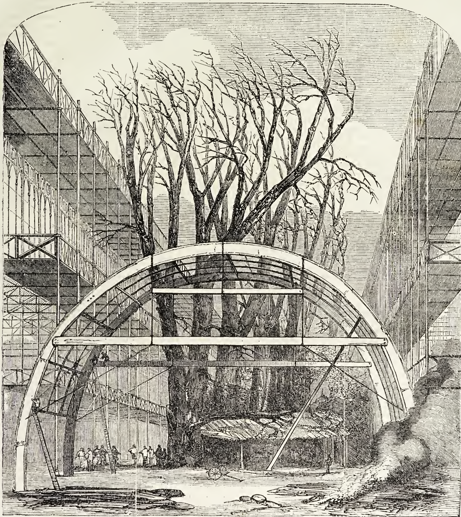
Visia del transept, con i preparativi per ergere l'armatura centrale
