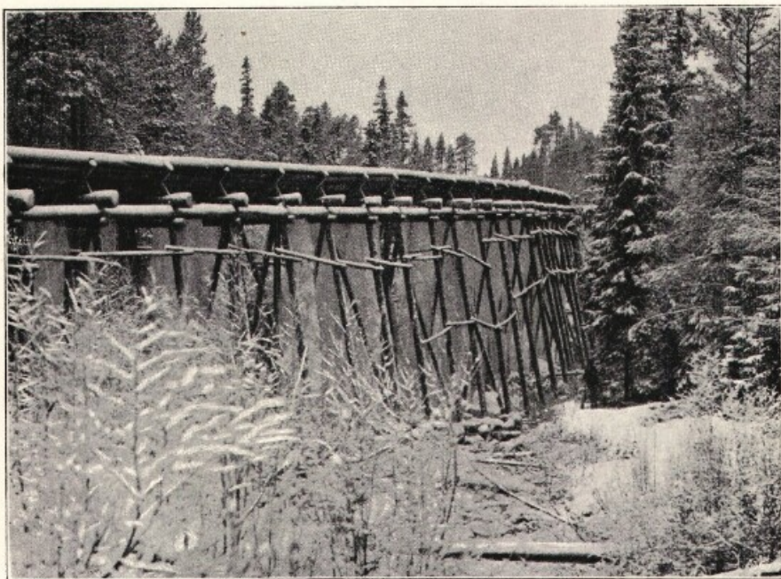
Fig. 167. Vattenledning för flottning af timmer, Hälsingland
