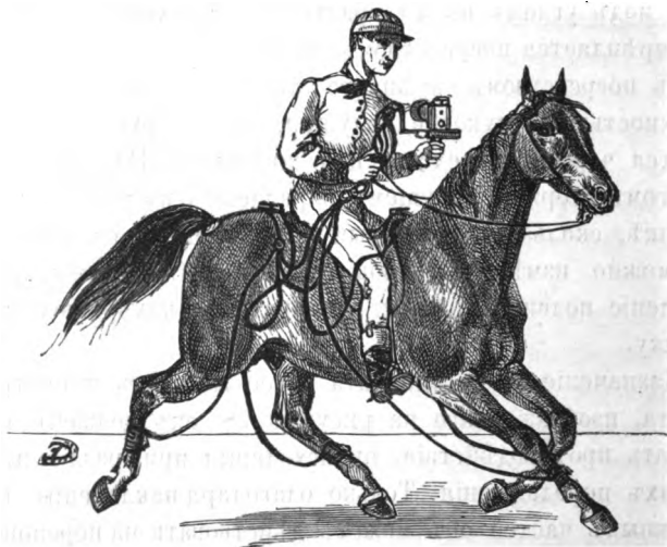
Рис. 44.—Этотъ рисунокъ изображаетъ лошадь, идущую рысью и снабженную всѣми испытующими аппаратами, всадникъ же держитъ въ рукахъ пишущій аппаратъ.—На загривкѣ и на крестцѣ лошади помѣщены аппараты, изслѣдующіе противодѣйствія.
