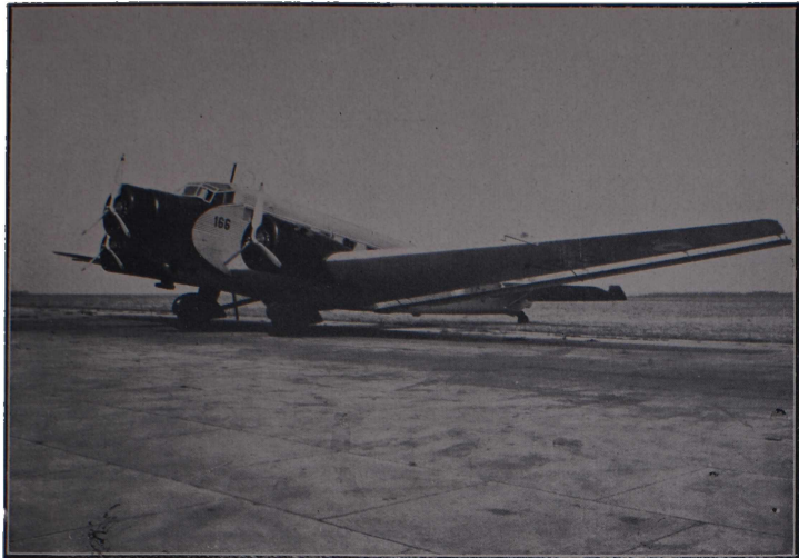
Avión Junkers Ju. 52 - 3 m., para transporte y enseñanza en vuelo.
