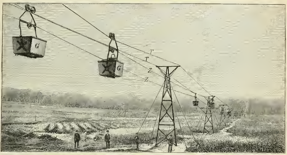
6. Seilbahnstrecke in flachem Terrain, bei Antonienhütte in Oberschlesien.
