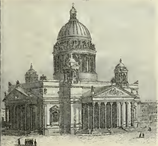
5. Kathedrale zu Petersburg, v. R. de Monferrand 1819—58 erbaut.
