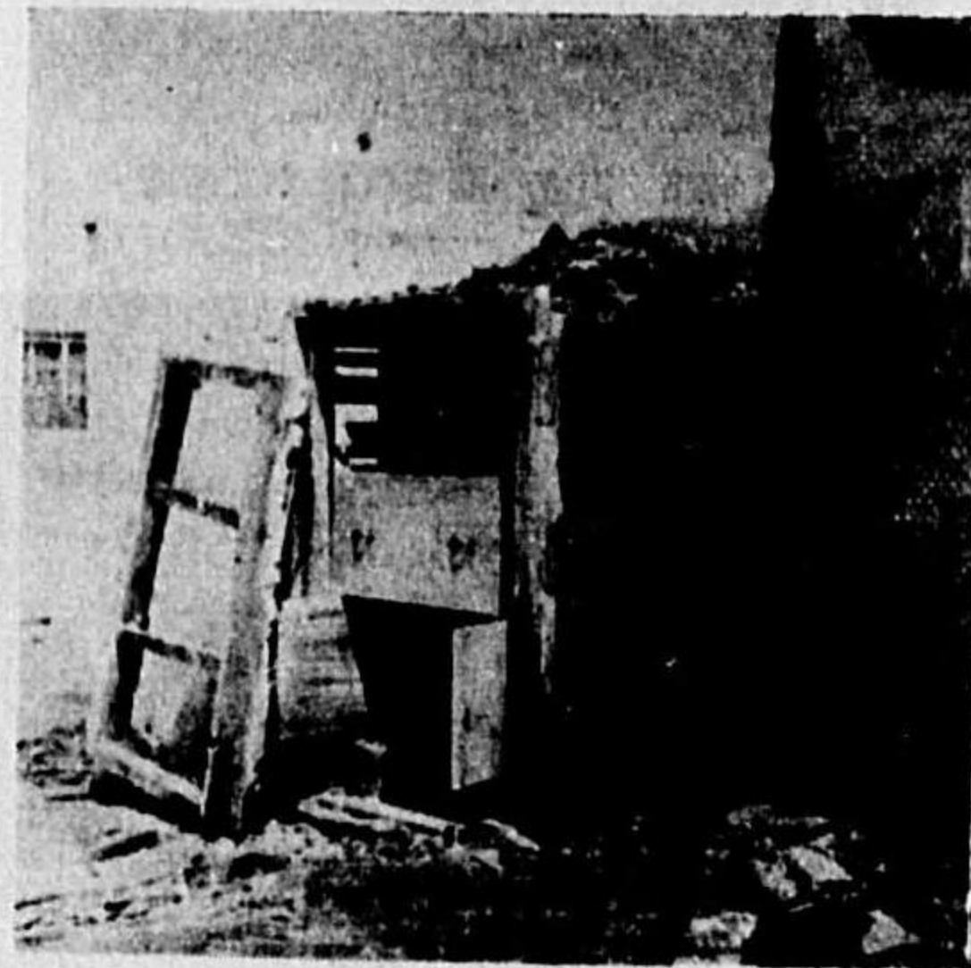
寫眞第32 實驗後開扉せる安全庫
