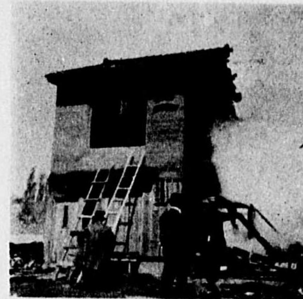
寫眞第23 實驗直後の②號家屋(西面)
