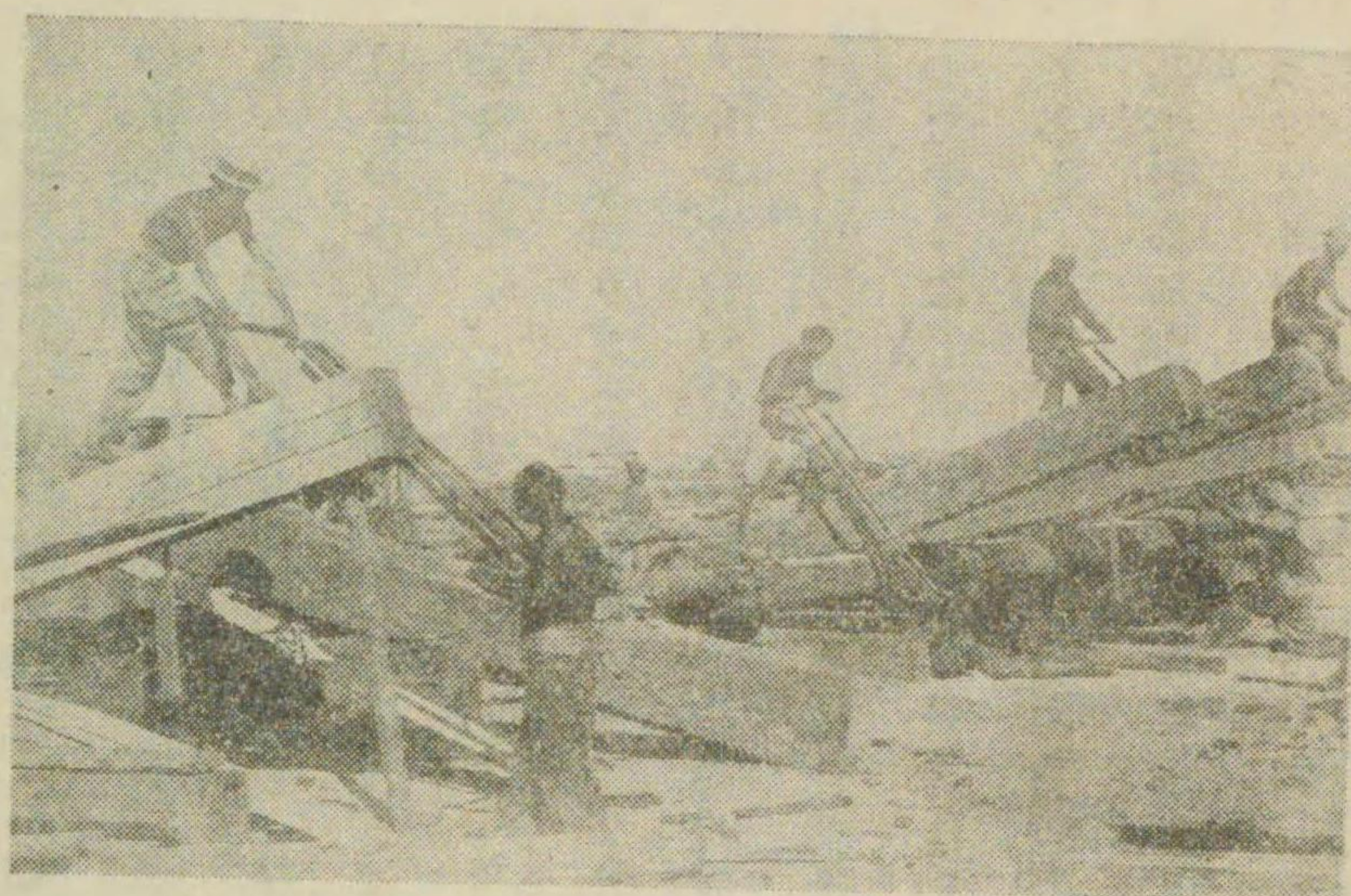
支那木材商に見る挽木のき鋸の景光ふ取、上二下と互に胸にす押を要領とす
