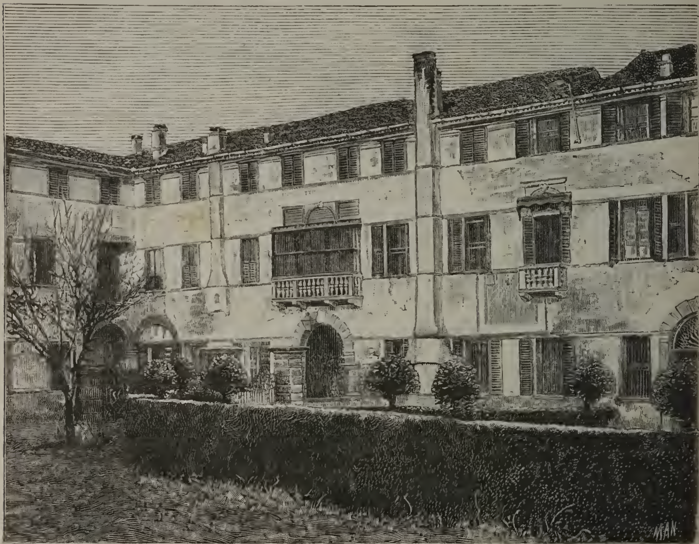
Casa annessa all'orto dal quale osservò Galileo in Padova.
