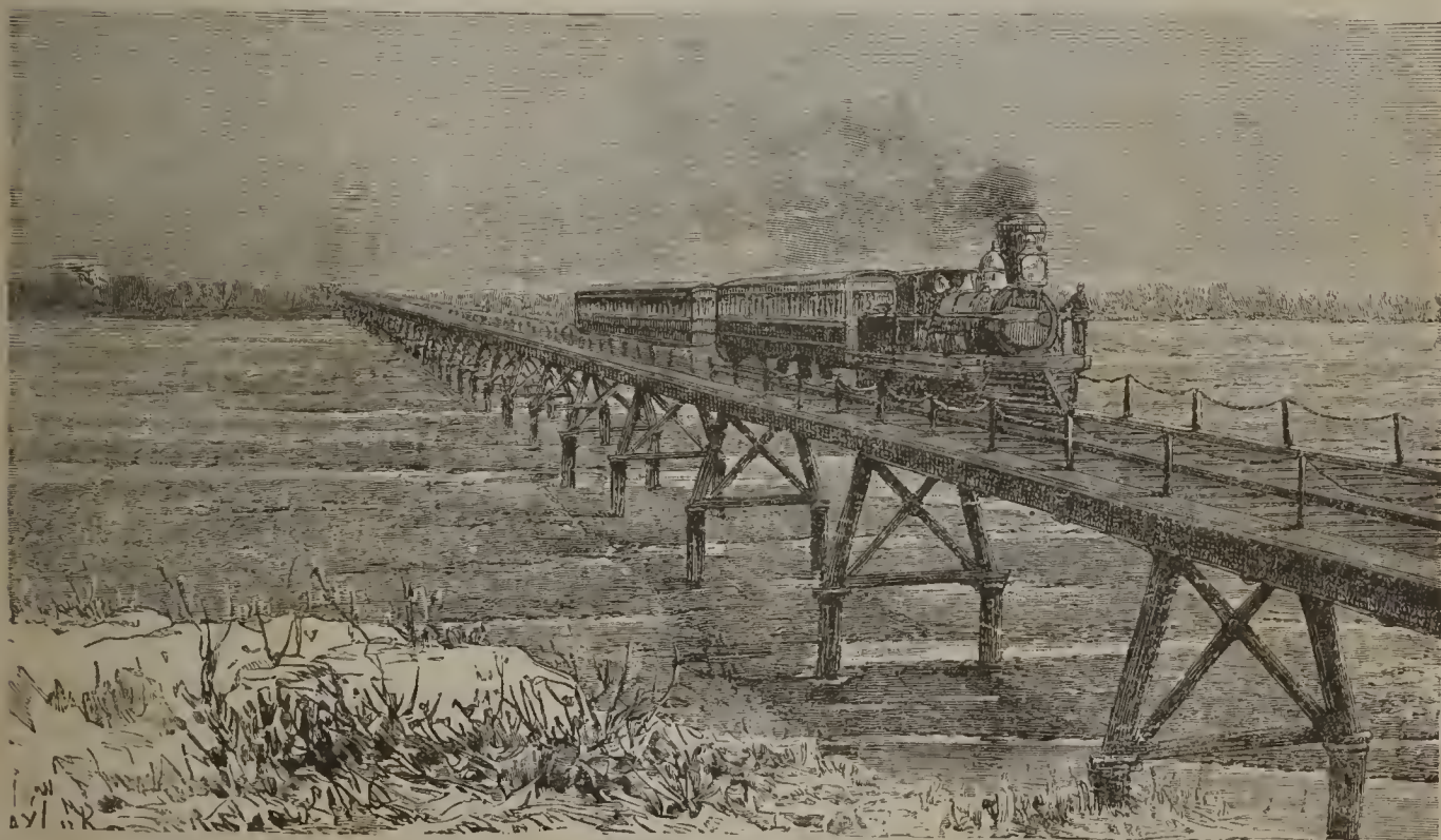
Ponte sul rio Segundo.
