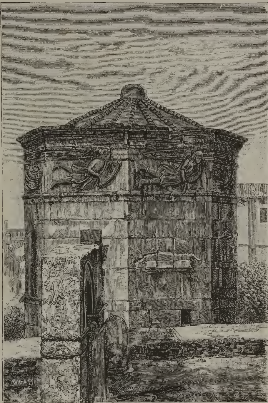
La torre dei Venti in Atene.
