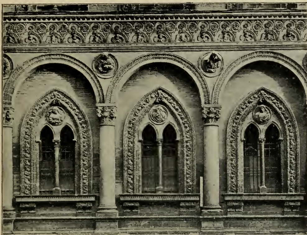
Fig. 454. Milan. From the Façade of the Ospedale Maggiore.
