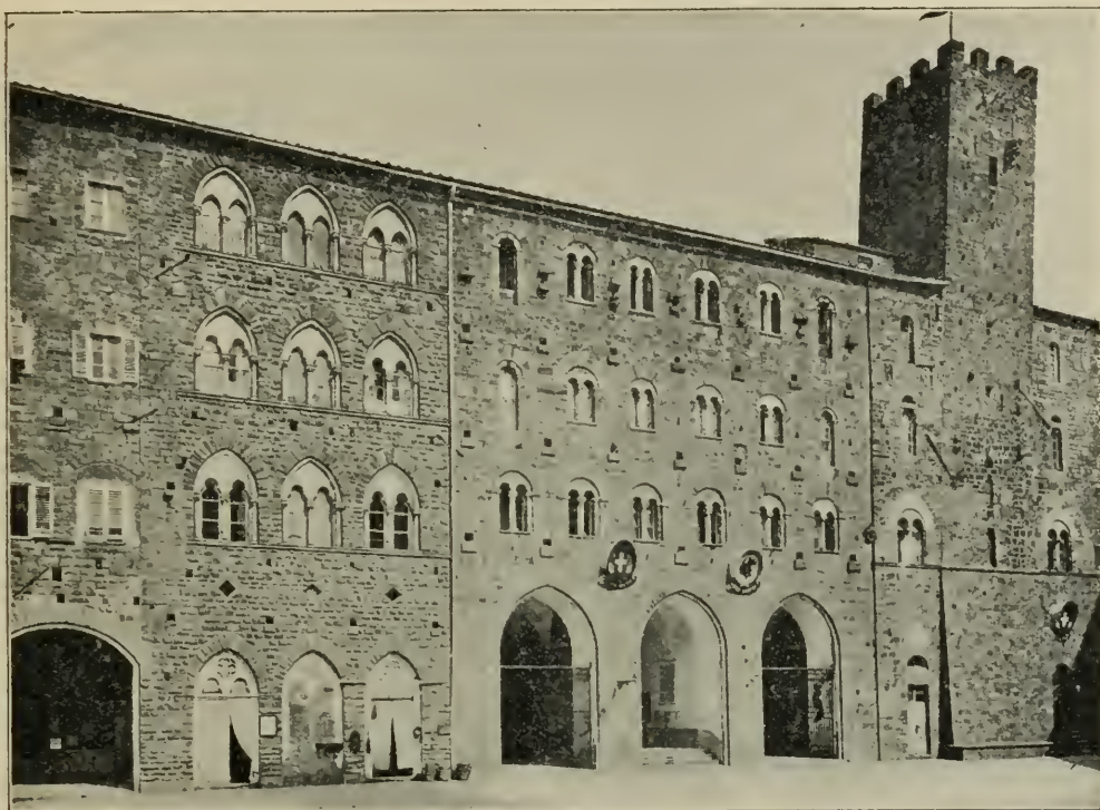
Fig. 447. Volterra. Palazzo Pretorio.
