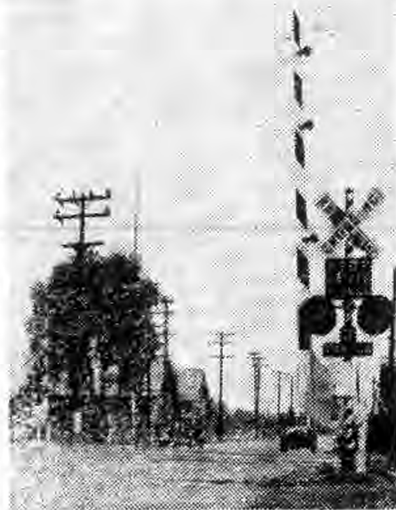
六圖 伊諾利中鐵路新設之平交道防護設備，當列車駛近時，其臂形即自自動落下，以阻止公路上之車輛行進
