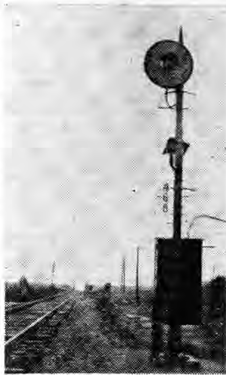
圖 四 加 拿 大 國 家 鐵 路 新 設 之 自 動 聯 鎖 站 號 誌
