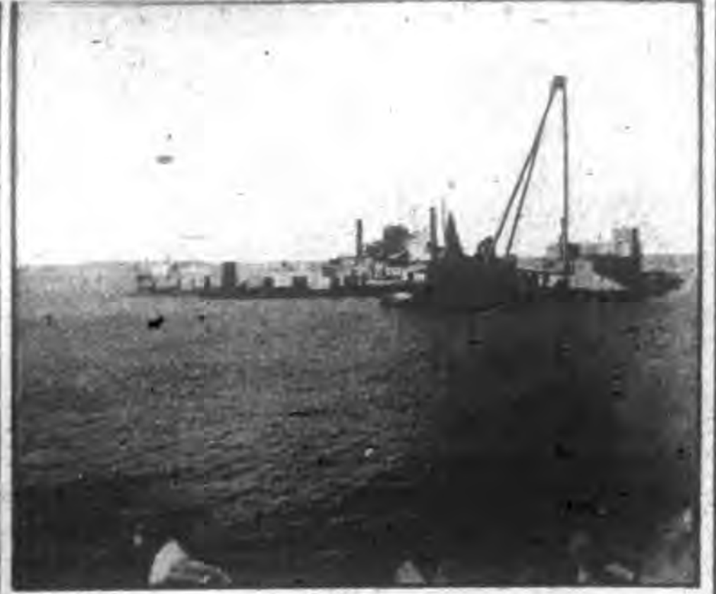
份部一之頭碼成造已(上) 機重起之用所時築建(左)
