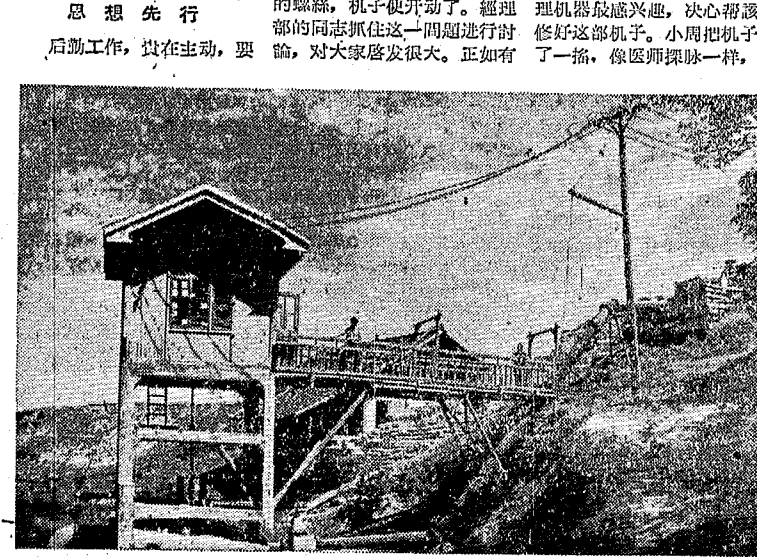
长沙县靖港机电排灌站丰兴机台，安装有一台九五五型电动排灌机，可排灌近四千亩田，保证该区今年农业生产得到了丰收。
