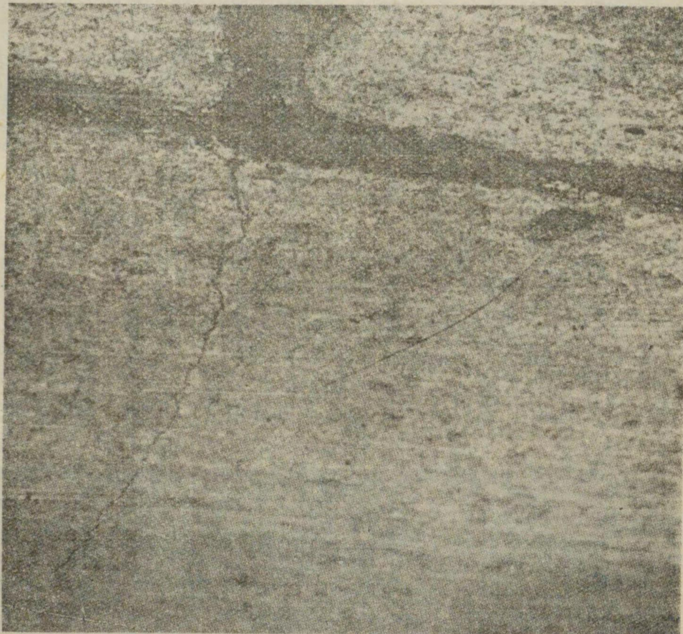
第二十三圖 斜置交列接合に對する區間の裂罅を示す圖
