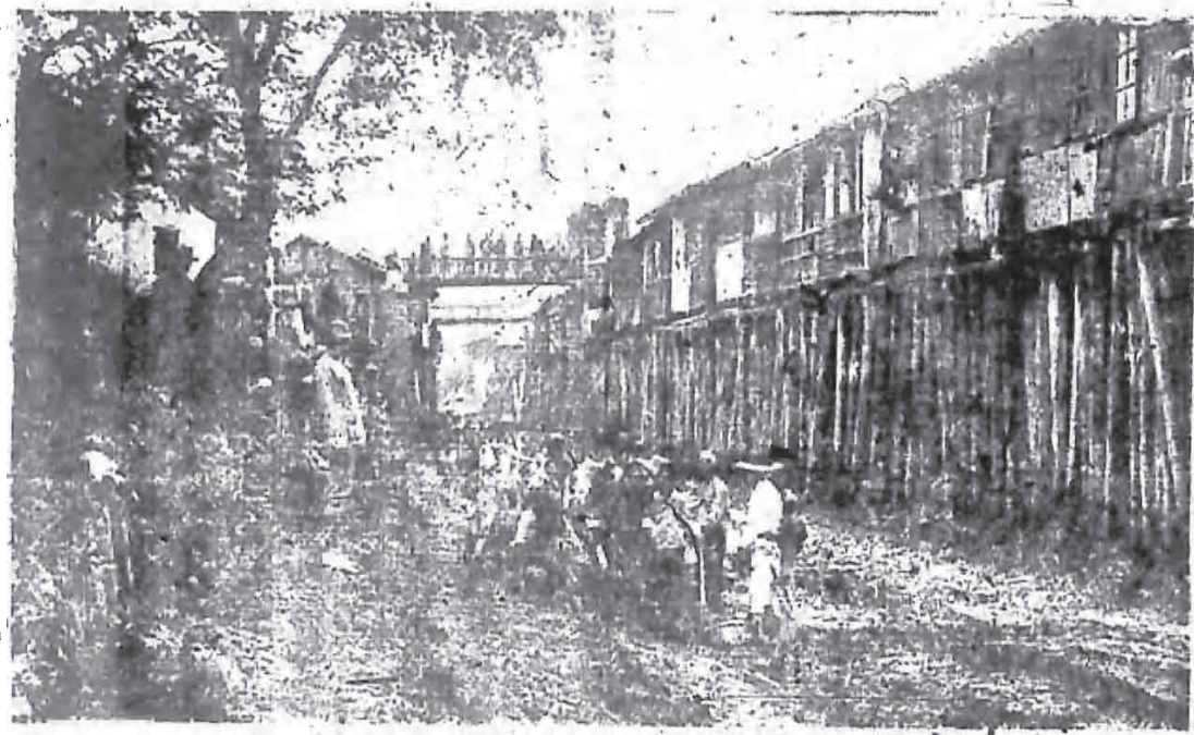
傳益民衆之本區疏浚夾河工程
