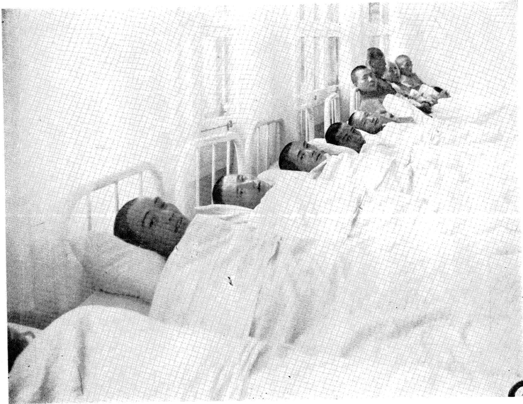
戒 煙 病 室 之 一 部
