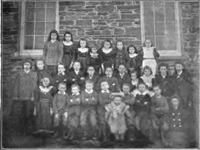
PLANT CYMRU. CXXX. PLANT BWLCH Y LLAN.
