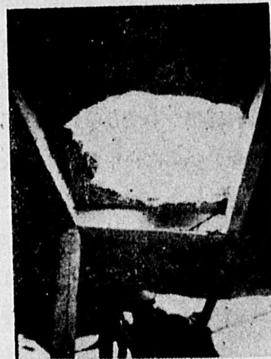
第159圖 鉄筋コンクリート造建築物の屋根に対する爆弾の効力 (陸軍省檢閲済)
