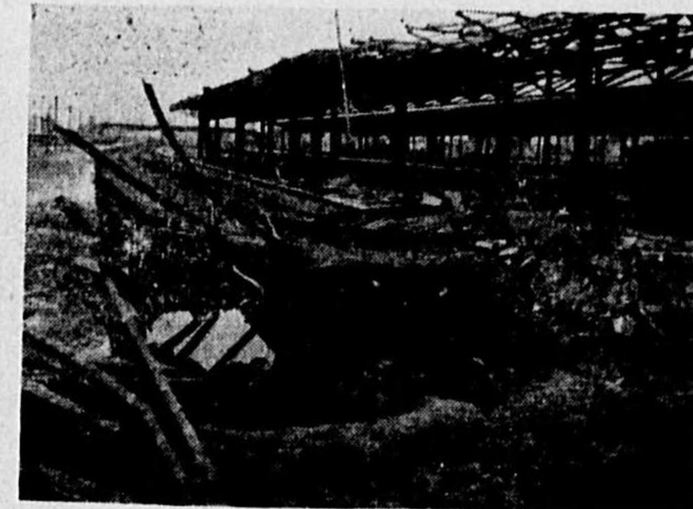
第153圖 鐵骨造建物に対する爆弾の效力 (支那事變、上海北停車場歩廊の上屋、陸軍省檢閲濟)
