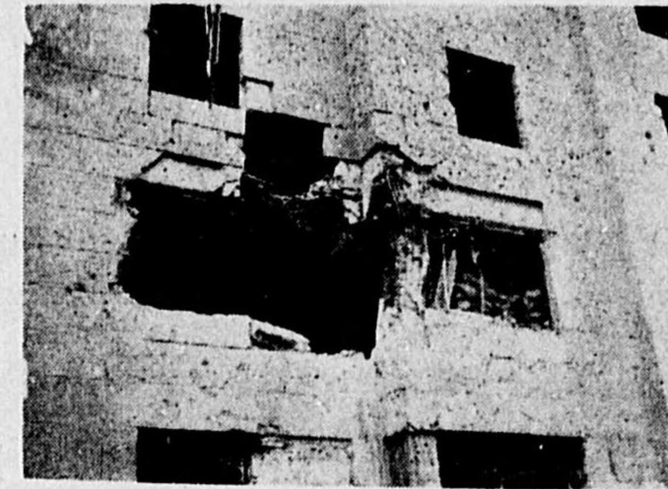
第160圖 鉄筋コンクリート造建築物の側壁に對する爆弾の効力 (陸軍省檢閲済)
