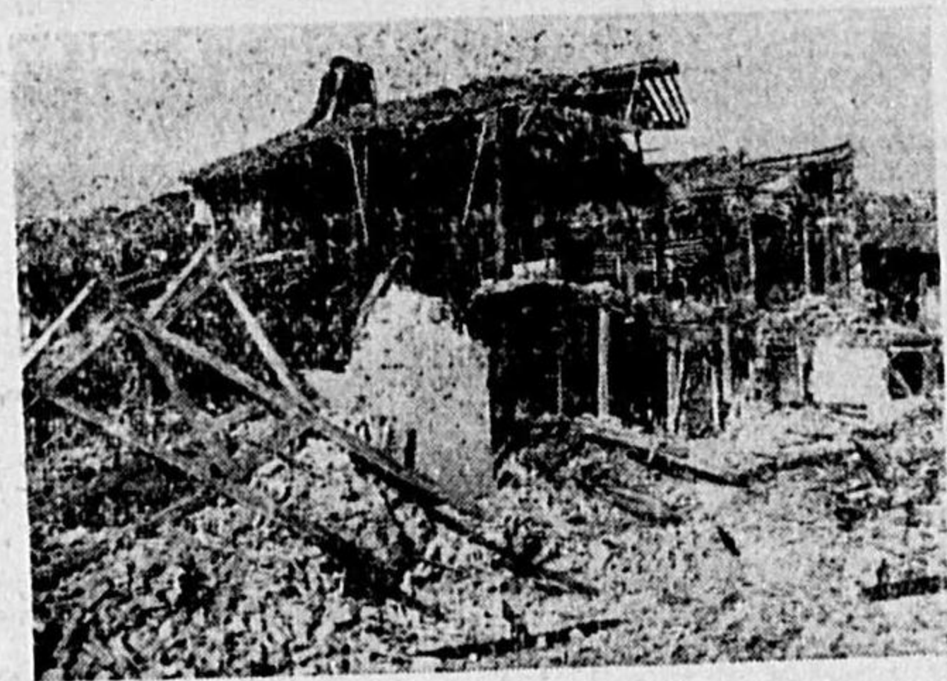
第148圖 木造家屋(壁は煉瓦造)に対する爆弾の効力
