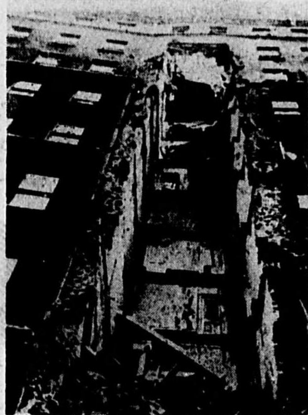
第150圖 煉瓦造高層建築(床組木造)の爆弾による被害 1) (今次大戰、歐洲某市内)
