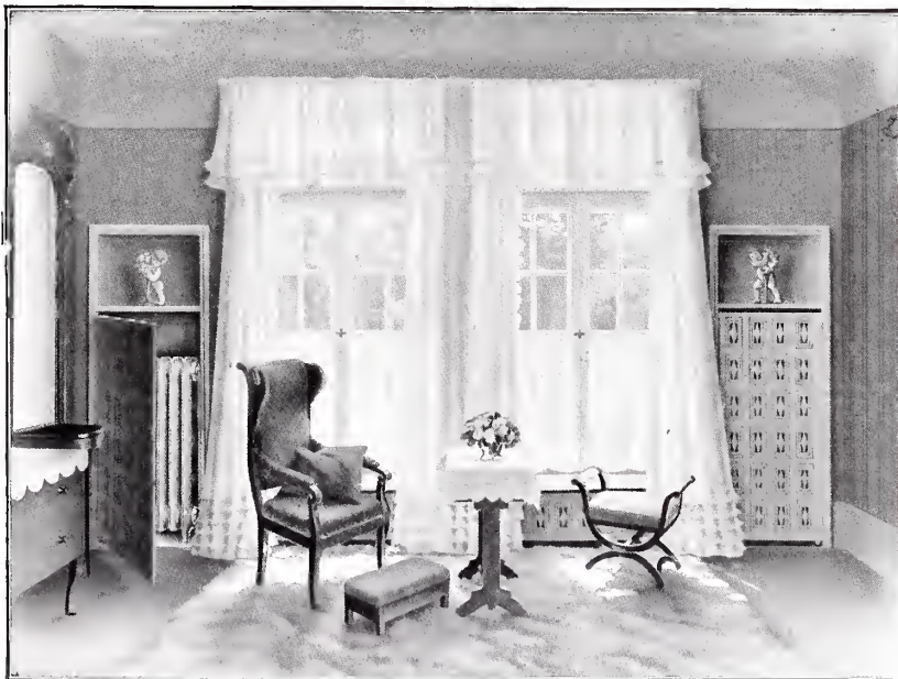
National-Radiatoren mit Verkleidung seitlich und unterhalb des Fensters.
