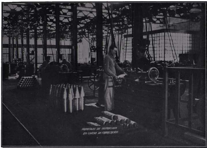
Proyectiles de instrucción en curso de fabricación.
