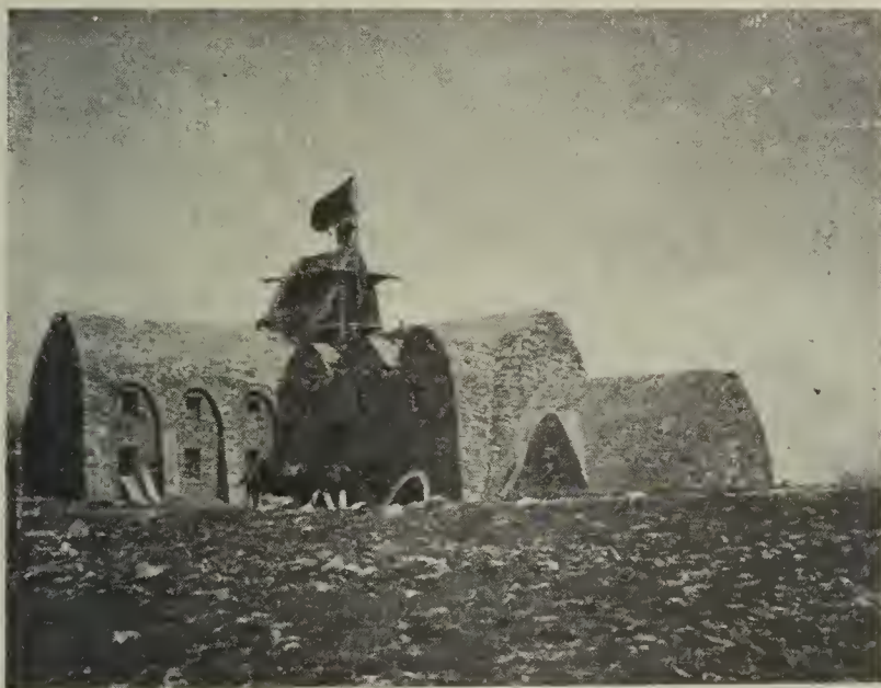
ESTAT DE LES OBRES EL DIA DE LA REVELLOSA
