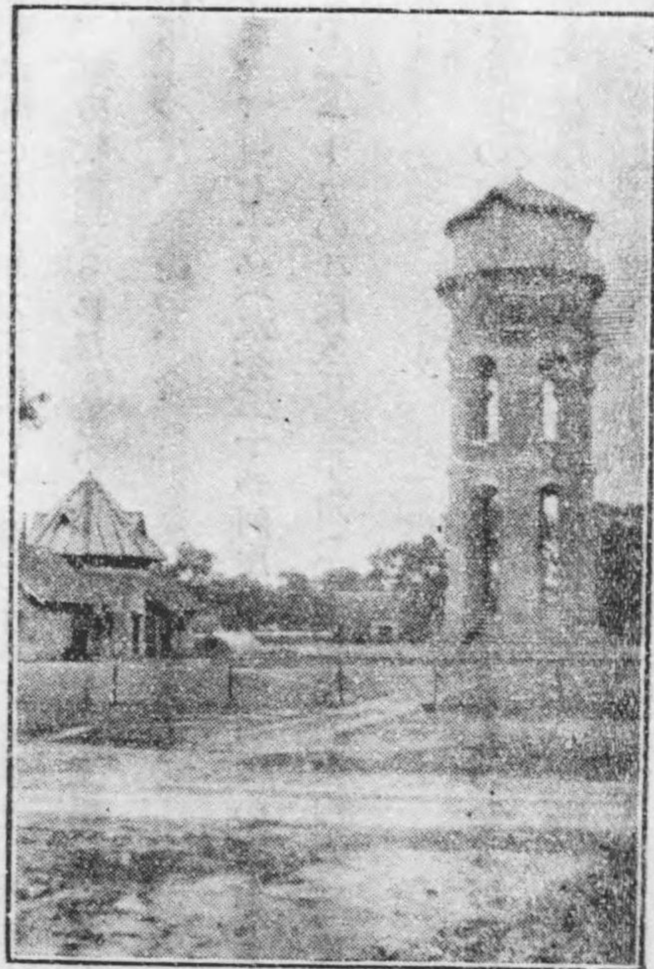
工場内使用給水
