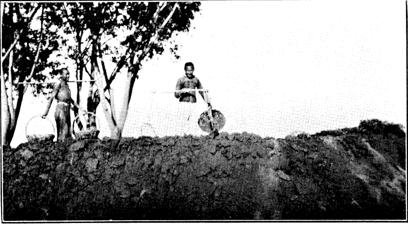
↑ 第三工段出土之情形
