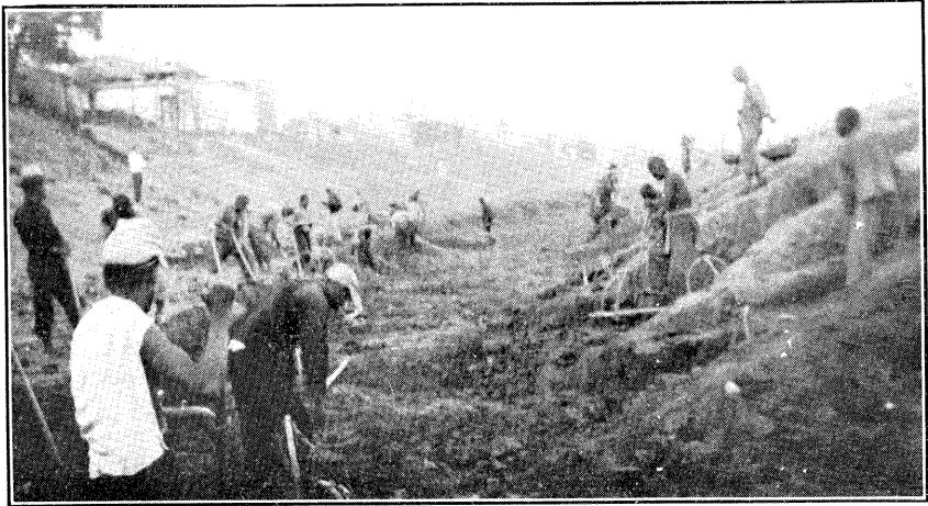
第五段楊柳鎮施工之情形
