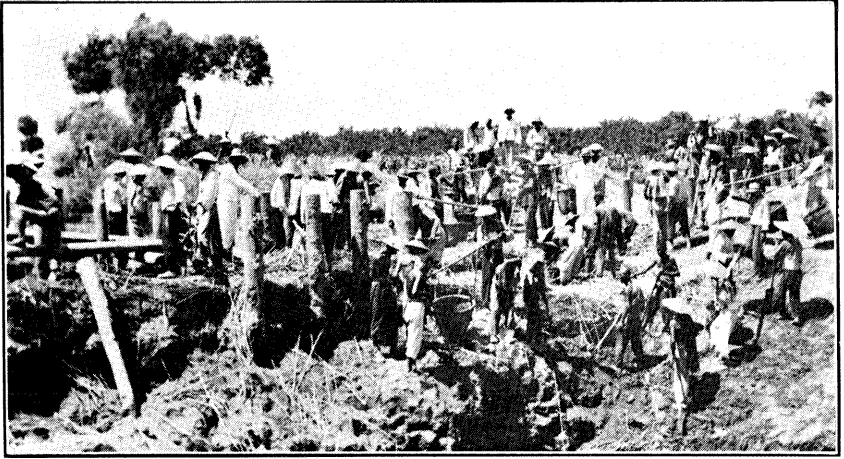
放 水 前 開 拆 上 壩 之 情 形
