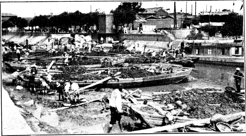
放水時開拆下壩裝運河淤之情形
