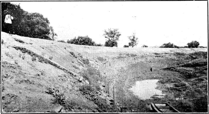
市內工僅有之護岸工程
