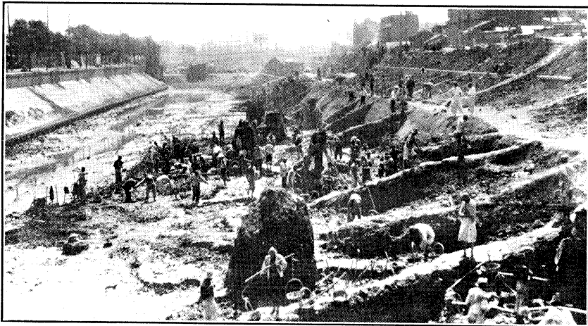
市內工段南運河出口土之情形
