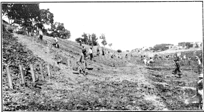
第五段西營門施工之情形
