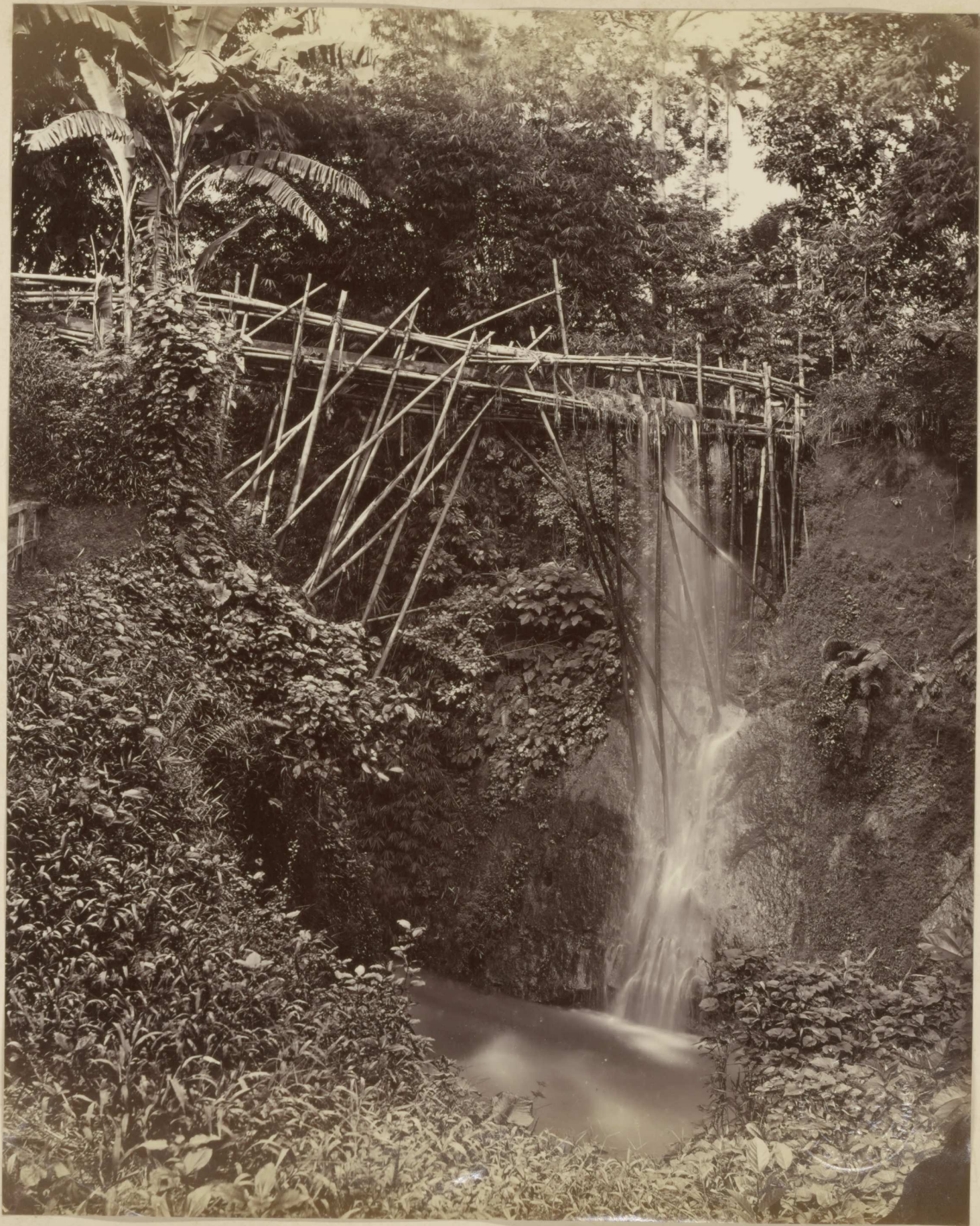
Buitengorg Wasserleitung für Reisfelder
