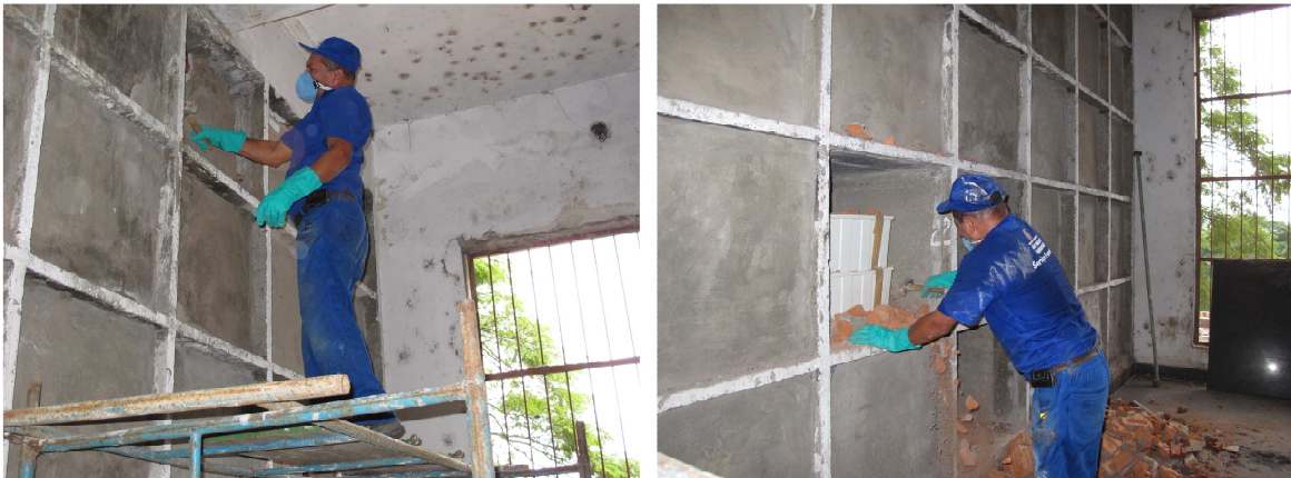
Procedimiento de apertura de nichos a cargo de personal del cementerio
