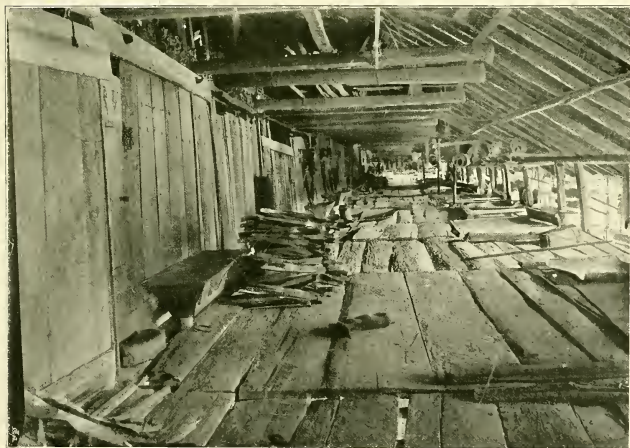
80. Die Galerie eines grossen Hauses der Kayans.
