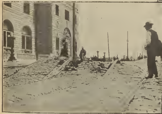
EFFECTOS DEL TERREMOTO EN EL EMPEDRADO DE LAS CALLES Y EN LOS RIELES DEL TRANVÍA
