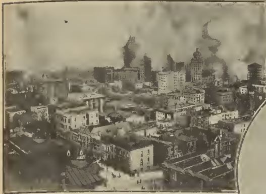
VISTA DE CONJUNTO DEL INCENDIO
