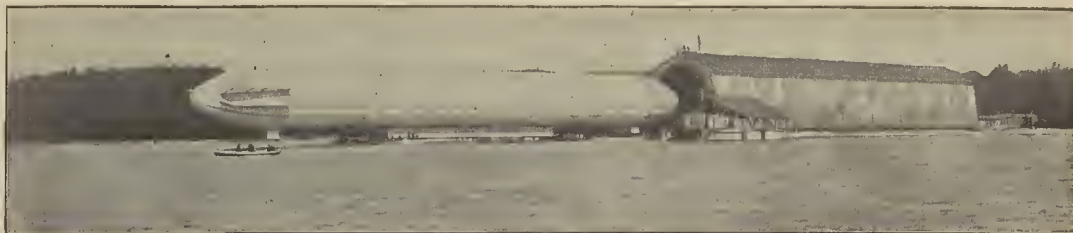
EL AERÓSTATO SALIENDO DEL COBERTIZO DE MANZELL, JUNTO AL LAGO DE CONSTANZA
