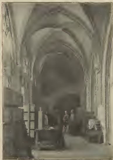
Fig. 4. - Vista interior del claustro. A la izquierda, dos ventanales, uno de los cuales reproduce la fig. 1; á la derecha, la puerta del aula capitular.
