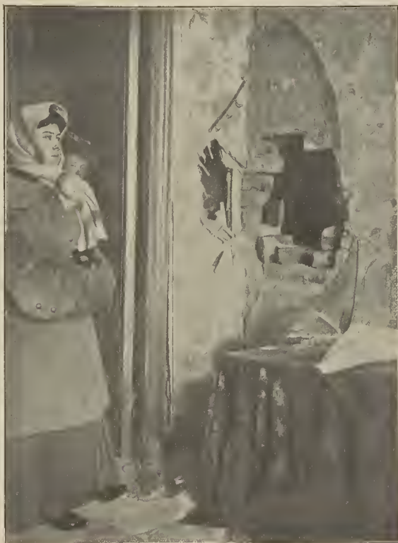
Rusia.—Disturbios revolucionarios en Moscú Efectos de un proyectil de artillería en una casa del arrabal Pressnaya (De fotografía comunicada por «Photo-Nouvelles.»)
