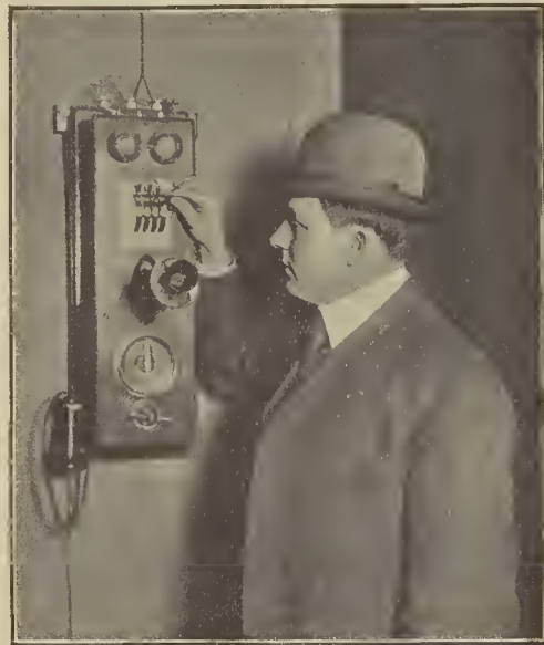
TELÉFONO AUTOMÁTICO SISTEMA LORIMER. - Fig. 1. Aparato transmisor (De fotografía.)
