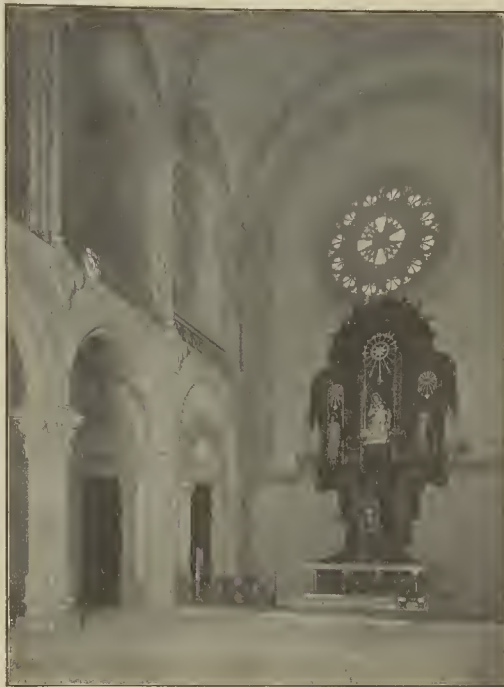
BARCELONA. - HOSPITAL CLÍNICO. VISTA INTERIOR DE LA CAPILLA (De fotografía de A. Merletti.)
