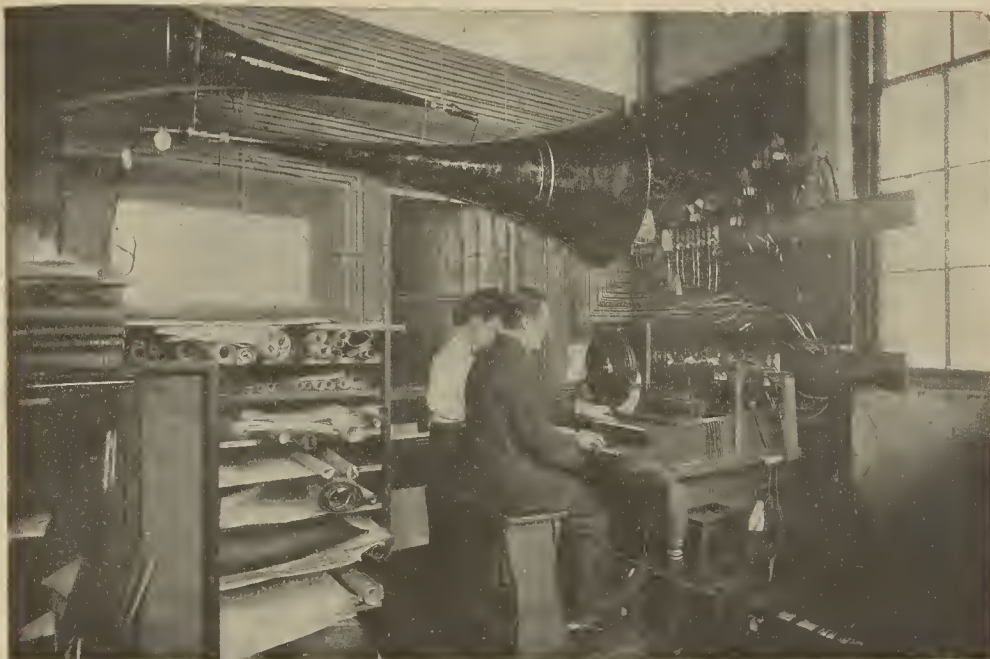
MÚSICA ELÉCTRICA. — TECLADO DEL INSTRUMENTO QUE PRODUCE MÚSICA POR MEDIO DE LA ELECTRICIDAD
