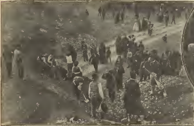
LOS HABITANTES DE BOSCOCREASE CONSTRUYENDO TRINCHERAS PARA DESVIAR LA LAVA
