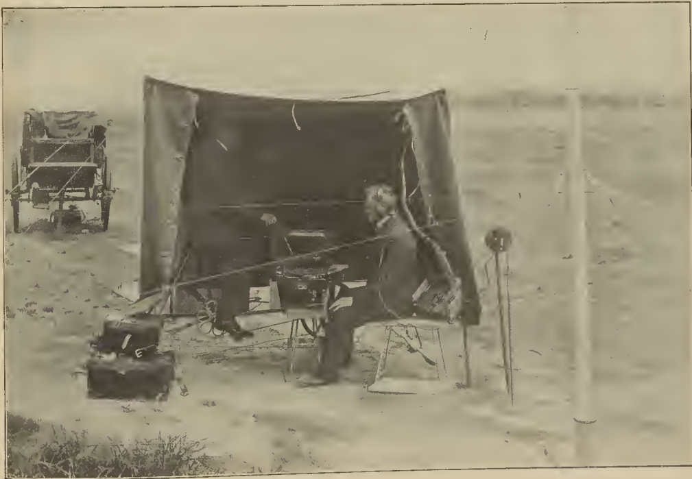
Telegrafía sin hilos.—Instalación de campaña en Nauen. Estación receptora. (De fotografías de E. Frankl, de Berlín.)
