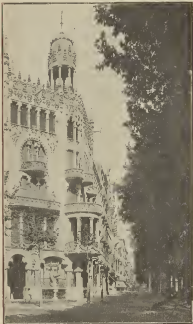
BARCELONA. — Casa propiedad de D. Alberto Lleó, obra del arquitecto D. Luis Doménech y Montaner. Premio del Excelentísimo Ayuntamiento en el concurso de edificios de 1905. (De fotografía de A. Merletti.)
