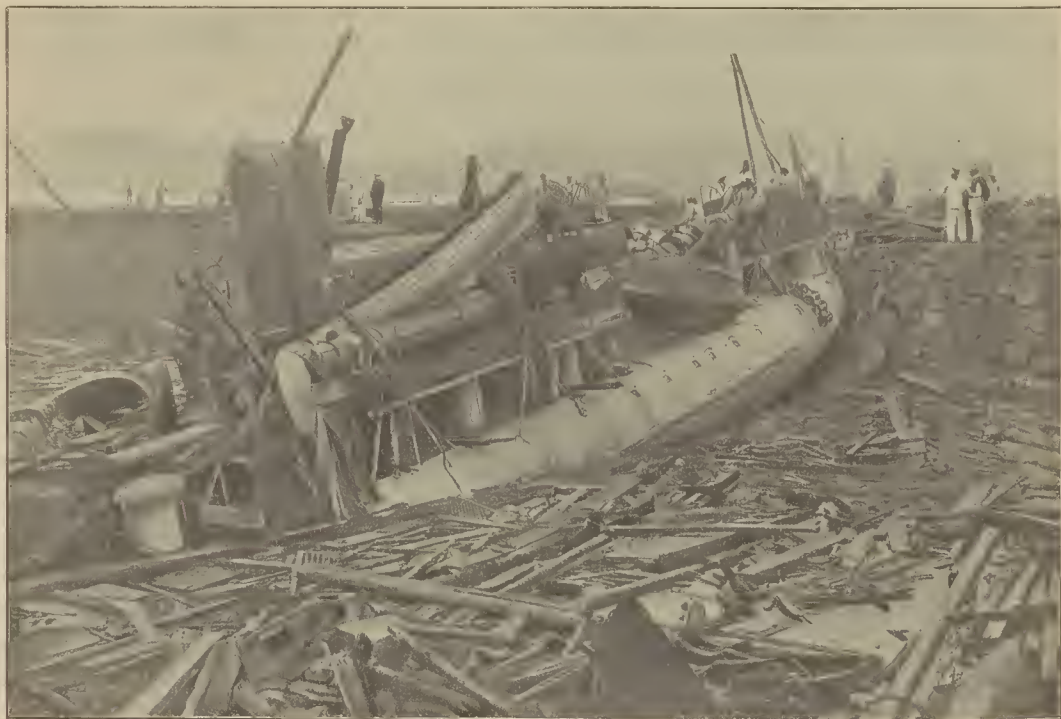
HONG-KONG. — Efectos del tifón de 18 de septiembre último. El torpedero francés Fronde lanzado contra un muelle. (De fotografía.)
