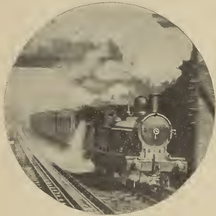
Un tren expreso tomando agua á toda velocidad En el momento de sacarse la fotografía acababa de llenarse el tanque y se ve el agua derramándose por las aberturas superiores
