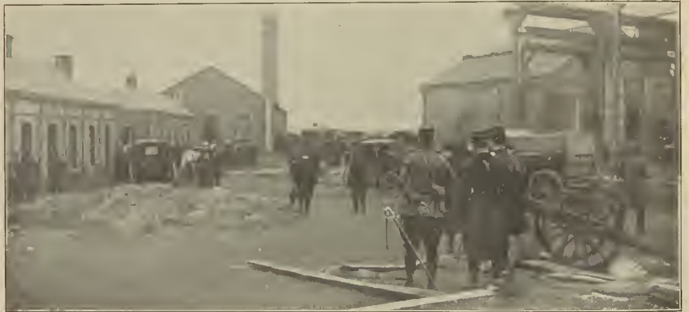
Vista general del pozo número 4. (De fotografía de M. Rol y C.ª)
