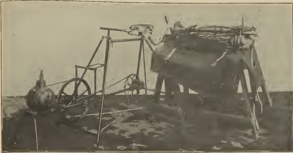
Telegrafía sin hilos.—Instalación de campaña en Nauen (Alemania). Aparatos de la estación receptora
