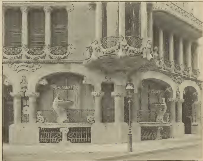
Detalles de la fachada de la planta baja y del primer piso de la casa de D. Alberto Lleó. (De fotografía de A. Merletti.)
