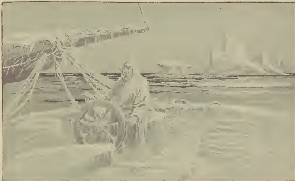
Tinonel muerto de frío, que continuó solitario en su puesto, agarrando con inerte mano la rueda del timón y mirando el rumbo, con ojos sin vista
