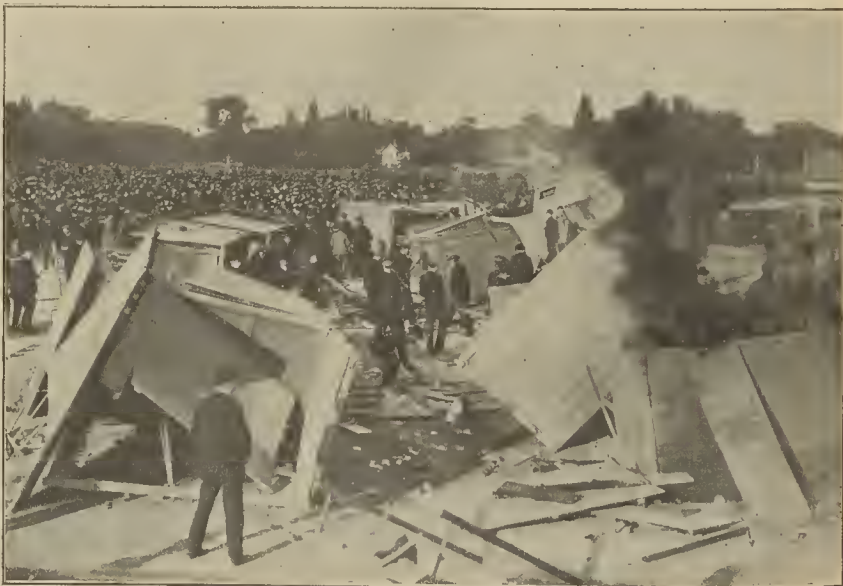
PARÍS.—GRAVES DESÓRDENES OCURRIDOS EN EL HIPÓDROMO DE LONGCHAMP EL DÍA 15 DE LOS CORRIENTES. LOS PABELLONES DE LAS APUESTAS MUTUAS INCENDIADOS. (De fotografía de M. Rol y C.)
