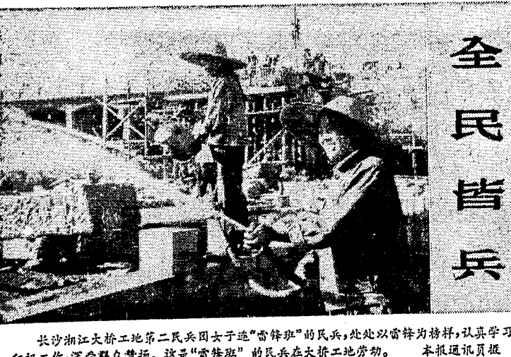
长沙湘江大桥工地民兵女工“雷锋班”的民兵，处处以雷锋为榜样，认真学习，积极工作，深受群众赞扬。这是“雷锋班”的民兵在工地劳动。 本报通讯员摄
