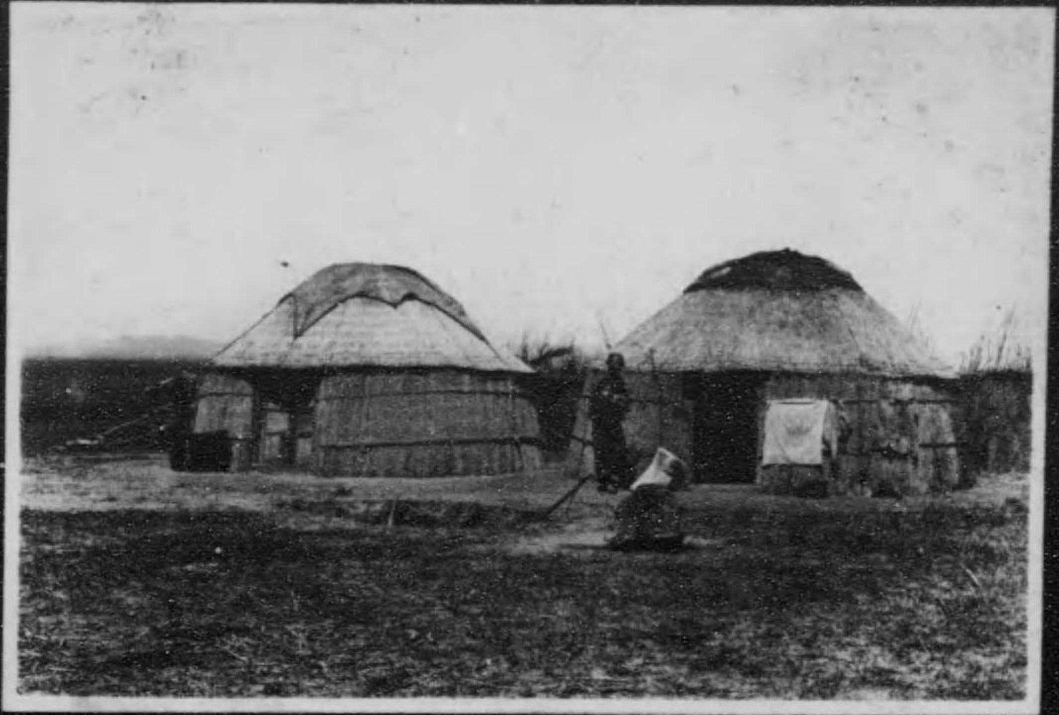
● 蒙古包 (蒙古) 蒙古人の家屋を包といふ。水草を追ふて遊牧する彼等の住居は移動式であるべきは當然である。圓錐狀に圍つた黄土製と云つた恰好、骨組みは適當の枝條を矢束に結ぶに類する丈夫なものである。冬季は厚皮を以て全部之を被覆して防寒する。背後に見ゆる結核の垣根は小車を屯する處である。包も開放地に置くに從つて固定的に泥を塗つたのや窓を明けたのや段々進化したものと見らる。 (印度の複製を模倣す)
