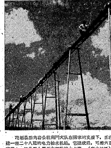
花垣县三角岩公社南門大队在国家的支援下，正在兴建一座二十八瓩的电力抽水机站。它建成后，可灌六百多亩田土。这是工人们正在架设出水管。(唐大柏摄)
