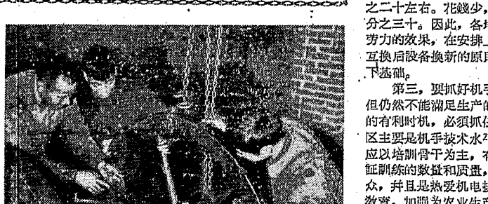
邵阳农业机械厂的工人，正在检修农业排灌机械，修理质量高，做到不合格不出厂。这是他们在装配1235柴油机。
