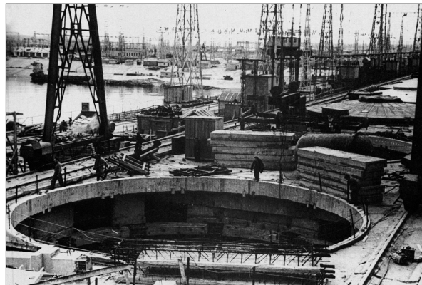
Будівництво Кременчуцької ГЕС. 1960.
