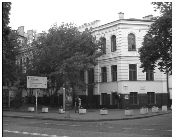
Будинок Київської духовної консисторії по вул. Володимирській, 24. Фото 2008.
