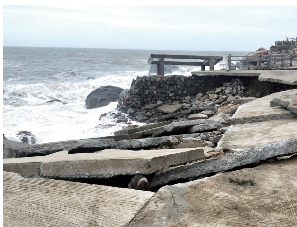
图6 广东省阳江市闸坡镇沿海护岸受损 拍摄时间：2022.7.3 坐标：21°34'N, 111°52'E
