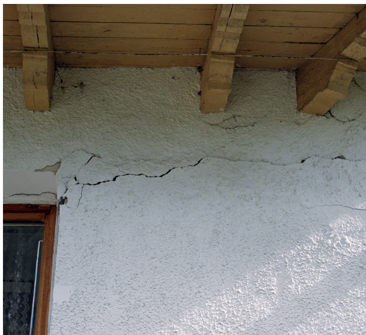
На знімках: Ялтинський дім Антона Чехова викладений із бутового каменю, через зсуви ґрунту буквально тріщить по швах
