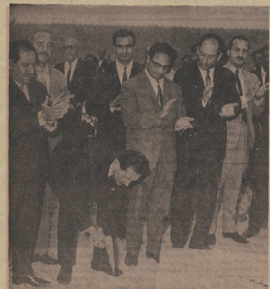
بازدن اولین کلنگ ساختمان راه آهن یزد کرمان فعالیت برای اجرای طرح تکمیلی پروژه عظیم ذوب آهن ایران آغاز گردید
