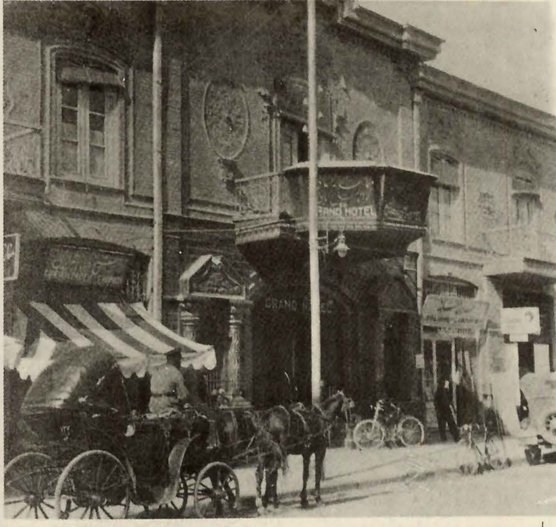
منظره ای از خیابان لاله زار زمانی که اداره روزنامه اطلاعات در این خیابان قرار داشت. خیابان لاله زار در آن زمان زیباترین و شلوغ ترین خیابانهای تهران بود هنوز هم لاله زار دارای مغازه های قشنگ و بزرگ و سینماها و تئاترهای متعدد است.
