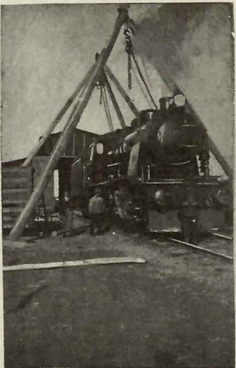
در ابتدای کار بواسطه فقدان جر قهیل لکوموتیوها را باینوسیله بلند میکردند
