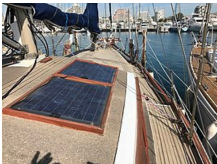
Panneaux solaires ouverts.
