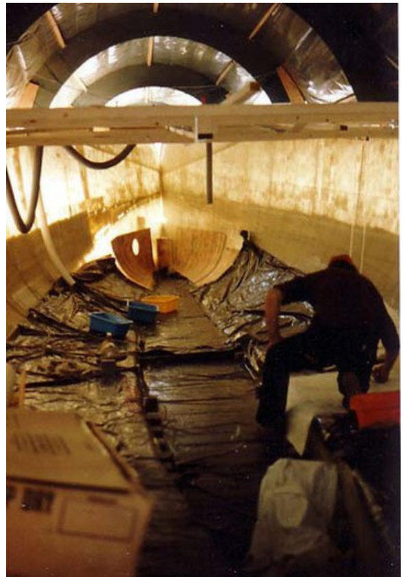
Pose du sandwich-balsa à l'étrave et préparation de l'orifice du premier propulseur d'étrave à turbine.
