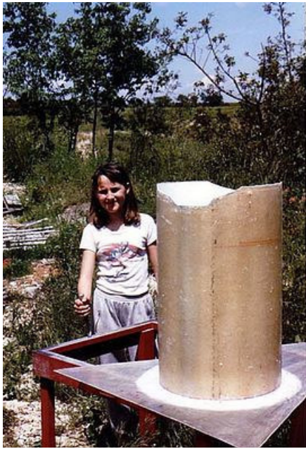
Préparation du puits à chaîne avant la pose de la cloison étanche.
