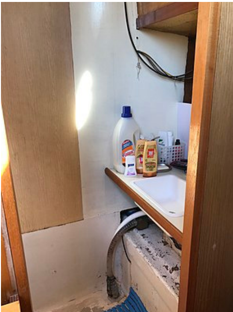
Douche en rénovation
