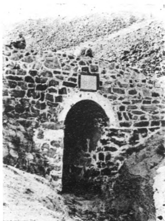
(六) 東水道東口太平橋
