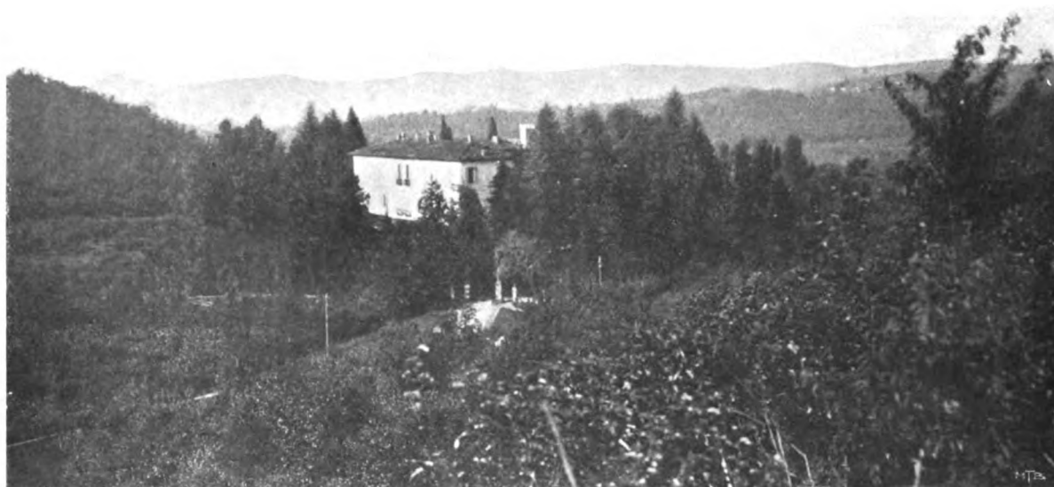
VILLA E GIARDINO DAL COLLE.
