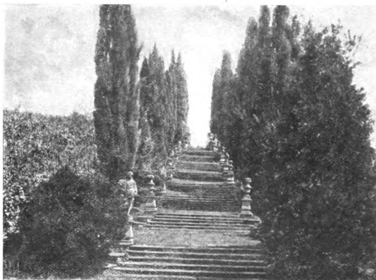
GRADINATA INTERNA NEL GIARDINO.
