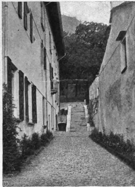
VIALE E GRADINATA VERSO LA SELVA, ALL'INIZIO DEI LAVORI DI RISTAURO (A SINISTRA IL PALAZZO, A DESTRA IL VILLINO).
