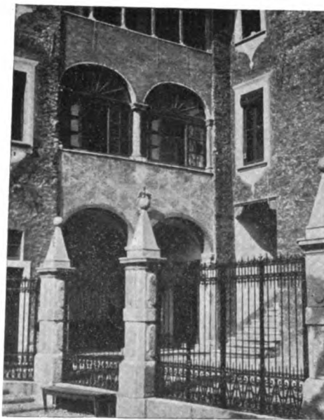
INGRESSO ALLA VILLA DAL PAESE.
