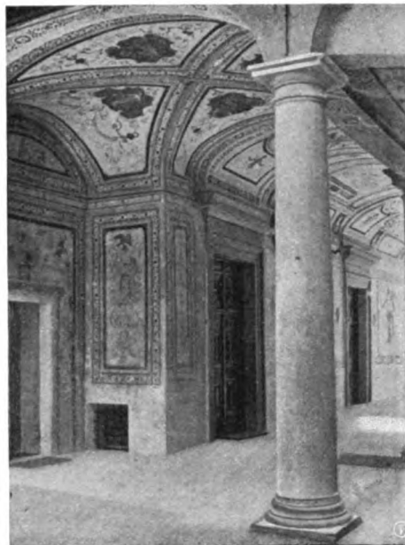
L'ATRIO DALLA CORTE DOPO LA DEMOLIZIONE DEL MURO CHE MASCHERAVA ANCHE LA COLONNA E LO SPESSORE DELL'ARCO AD AFFRESCO
