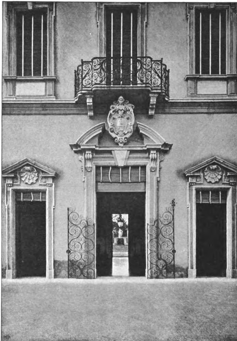
DETTAGLIO DELLA VILLA VERSO GIARDINO.
