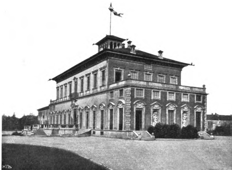
LA VILLA VERSO IL VIALE.
