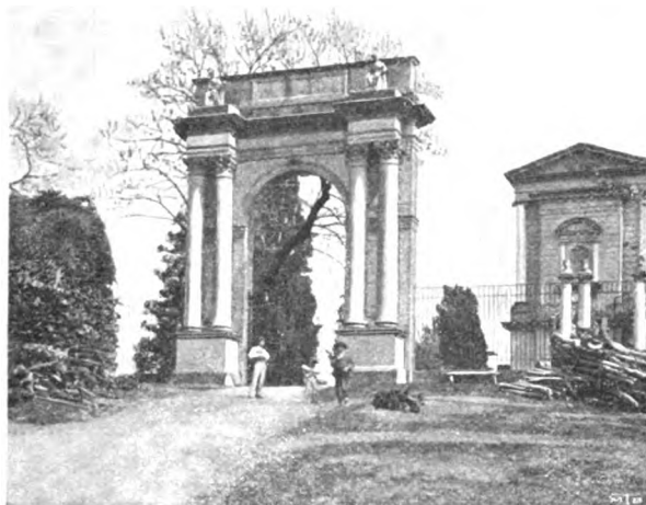
INGRESSO DELLA VILLA.
