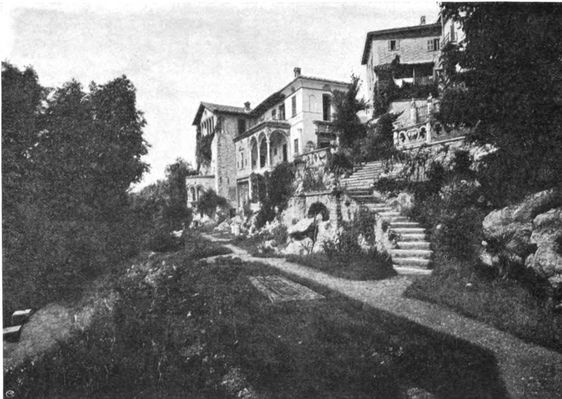
LA VILLA VERSO LO STRADONE.
