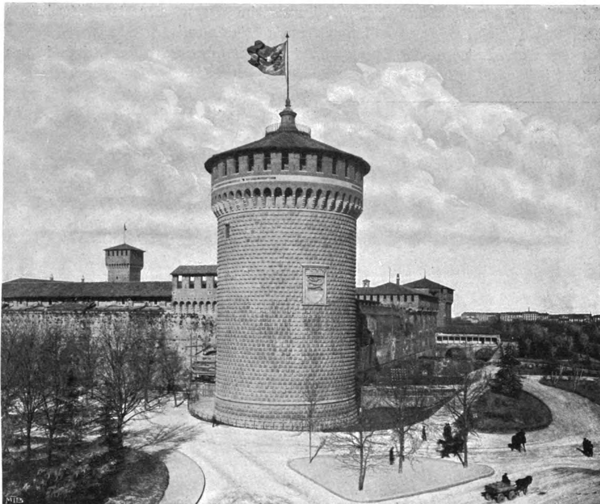
LA TORRE ROTONDA VERSO EST, RIPRISTINATA NEL 1894.
