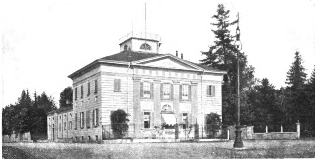
FRONTE DELLA VILLA.
