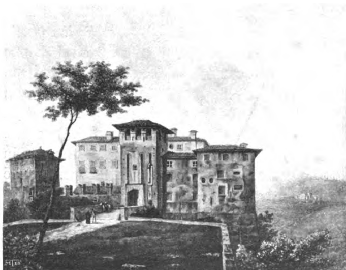
IL CASTELLO PRIMA DEL RESTAURO.
