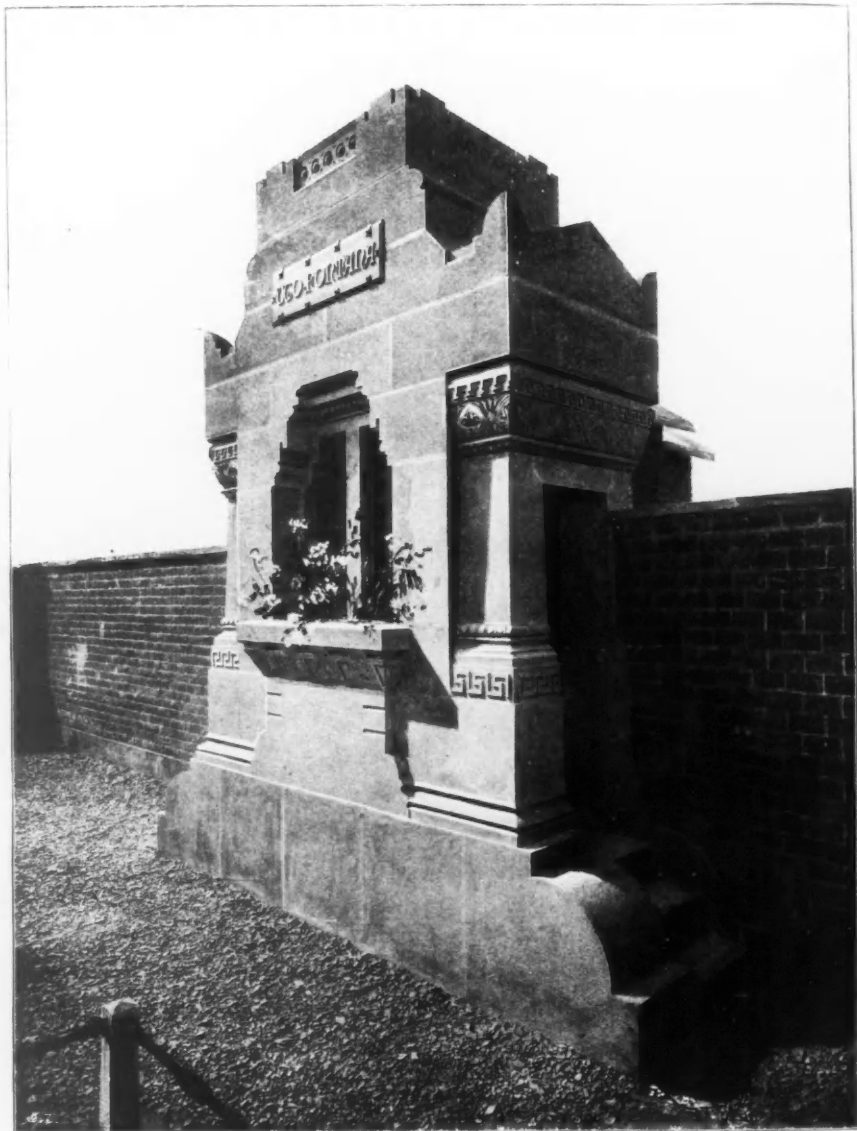
Deposito Cinerario nel Cimitero Monumentale di Milano, PROFESSOR GAETANO MORETTI, Architect, Milan ; LUIGI TENENTI, Ing.
