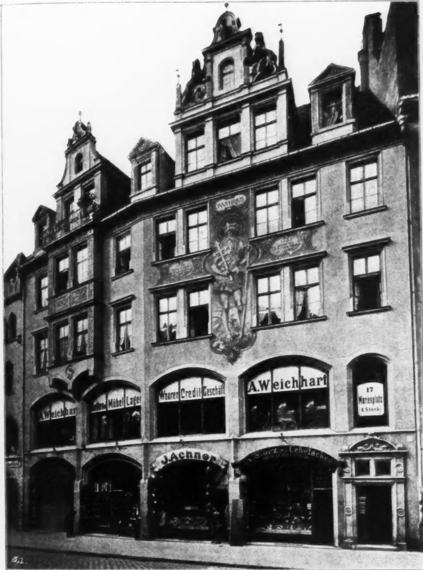
Wohn- und Geschäftshaus in Munich, Marienplatz 17, GABRIEL SEIDL, Architect, Munich.
