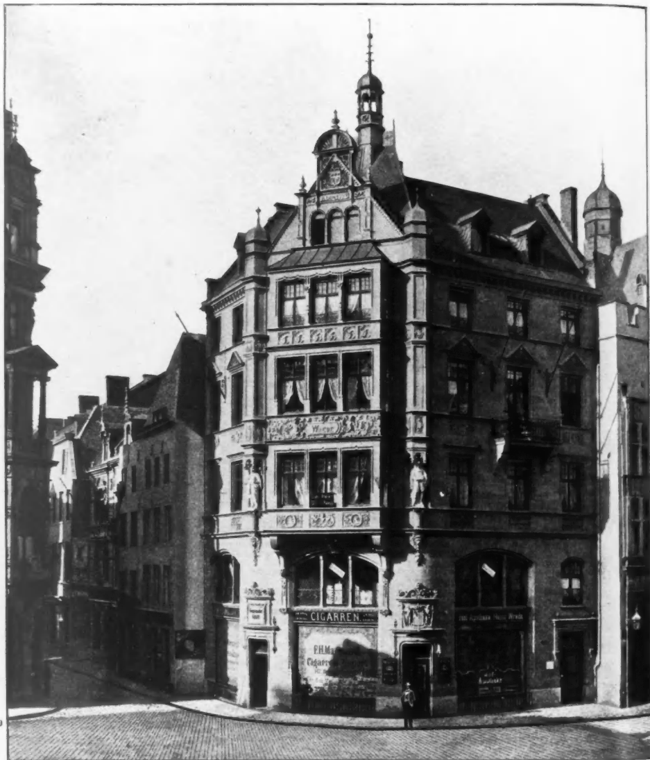
Haus Wrede, Köln a. R. , KAYSER AND VON GROSZHEIM, Architects, Berlin. (For Plan, see p. 122.)
