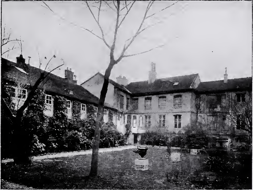
Le grand atelier du Nord et l'ancienne habitation de Jans.
