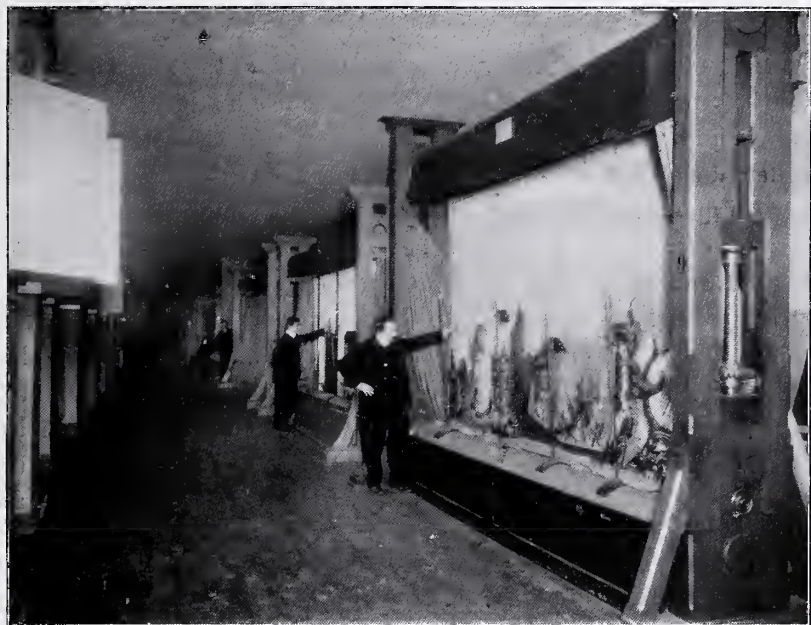
L'atelier du Nord. Vue intérieure.
