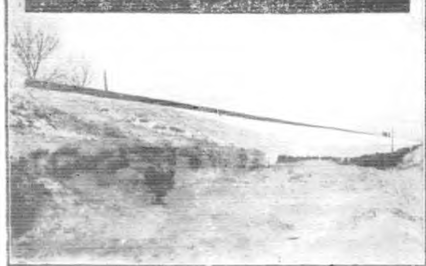
堵築永之河口第一期工程
